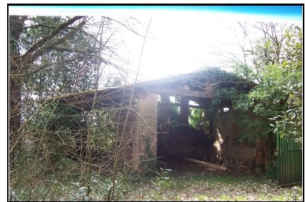
Foto: 09 Data ripresa: 27/03/2006 Edificio: 097 File: 097-09.JPG
