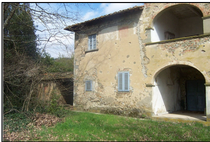
Foto: 04 Data ripresa: 27/03/2006 Edificio: 097 File: 097-04.JPG
