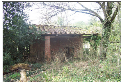
Foto: 08 Data ripresa: 27/03/2006 Edificio: 097 File: 097-08.JPG
