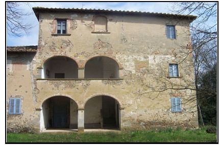
Foto: 03 Data ripresa: 27/03/2006 Edificio: 097 File: 097-03.JPG
