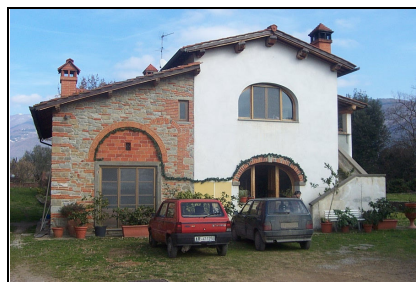
Foto: 03 Data ripresa: 06/02/2006 Edificio: 078/A File: 078-03.JPG
