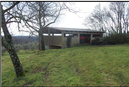
Foto: 10 Data ripresa: 21/02/2006 Edificio: 076/C File: 076-10.JPG
