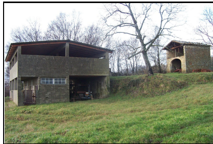
Foto: 11 Data ripresa: 21/02/2006 Edificio: 076/C File: 076-11.JPG
