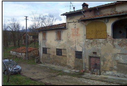
Foto: 02 Data ripresa: 22/02/2006 Edificio: 055 File: 055-02.JPG
