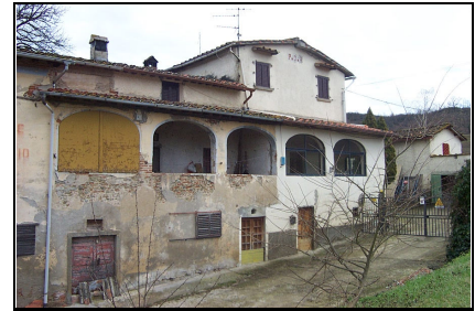
Foto: 03 Data ripresa: 22/02/2006 Edificio: 055 File: 055-03.JPG
