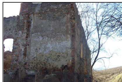
Foto: 03 Data ripresa: 02/02/2006 Edificio: 054 File: 054-03.JPG
