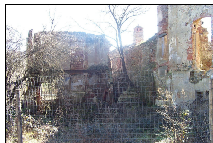
Foto: 06 Data ripresa: 02/02/2006 Edificio: 054 File: 054-06.JPG
