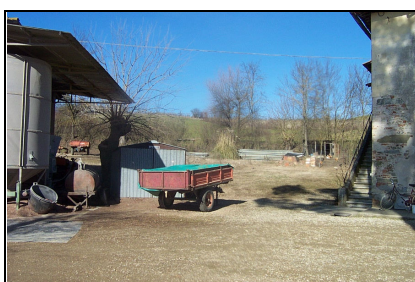
Foto: 14 Data ripresa: 02/02/2006 Edificio: 053/E File: 053-14.JPG
