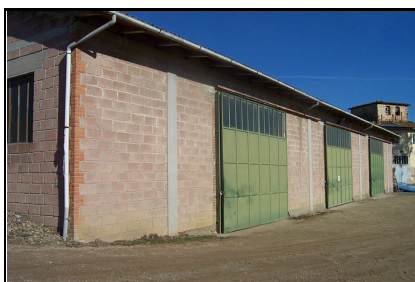
Foto: 08 Data ripresa: 02/02/2006 Edificio: 053/B File: 053-08.JPG
