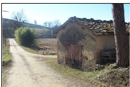
Foto: 13 Data ripresa: 02/02/2006 Edificio: 053/D File: 053-13.JPG
