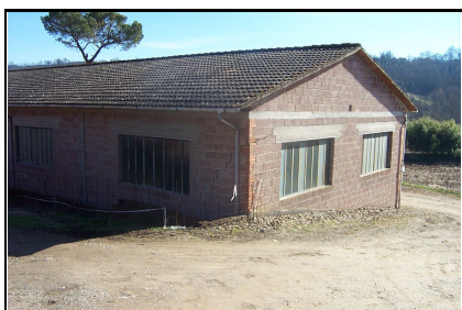
Foto: 07 Data ripresa: 02/02/2006 Edificio: 053/B File: 053-07.JPG
