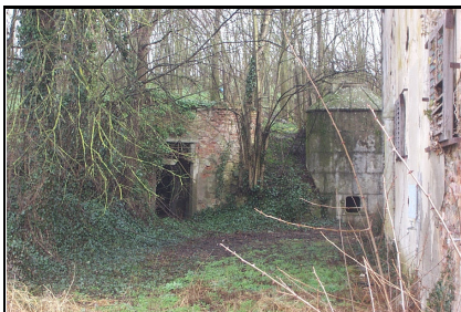
Foto: 07 Data ripresa: 24/02/2006 Edificio: 050/C File: 050-07.JPG
