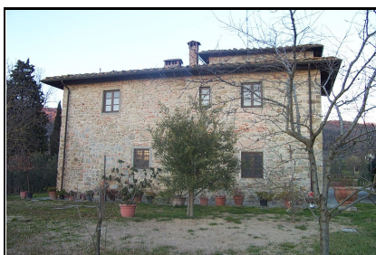
Foto: 08 Data ripresa: 02/02/2006 Edificio: 046 File: 046-08.JPG
