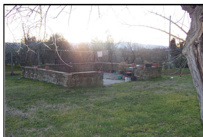
Foto: 12 Data ripresa: 02/02/2006 Edificio: 046 File: 046-12.JPG
