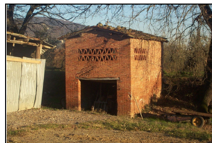
Foto: 06 Data ripresa: 02/02/2006 Edificio: 043/A File: 043-06.JPG
