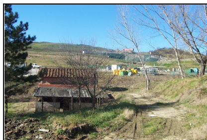
Foto: 14 Data ripresa: 02/02/2006 Edificio: 036/E File: 036-14.JPG
