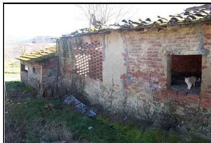
Foto: 08 Data ripresa: 02/02/2006 Edificio: 036/C File: 036-08.JPG
