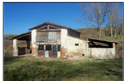
Foto: 15 Data ripresa: 02/02/2006 Edificio: 036/E File: 036-15.JPG
