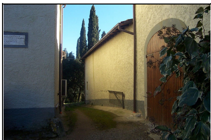
Foto: 19 Data ripresa: 02/02/2006 Edificio: 032/H File: 032-19.JPG
