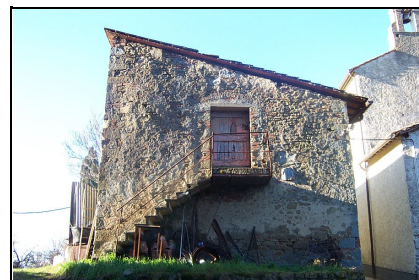
Foto: 21 Data ripresa: 02/02/2006 Edificio: 032/H File: 032-21.JPG
