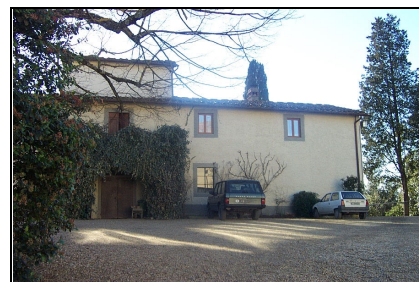
Foto: 18 Data ripresa: 02/02/2006 Edificio: 032/C File: 032-18.JPG
