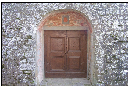
Foto: 34 Data ripresa: 02/02/2006 Edificio: 032/A File: 032-34.JPG
