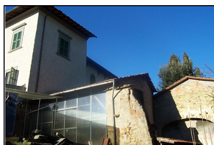
Foto: 15 Data ripresa: 02/02/2006 Edificio: 032/F File: 032-15.JPG
