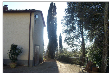
Foto: 24 Data ripresa: 02/02/2006 Edificio: 032/C File: 032-24.JPG
