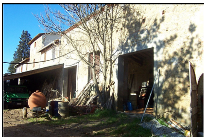
Foto: 22 Data ripresa: 02/02/2006 Edificio: 032/H File: 032-22.JPG
