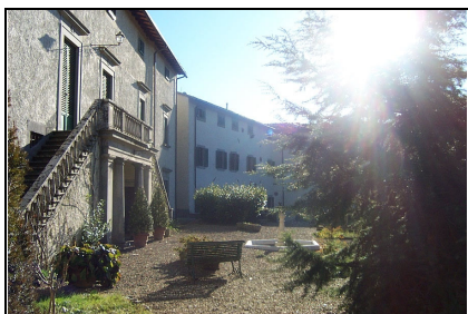
Foto: 04 Data ripresa: 02/02/2006 Edificio: 032/A File: 032-04.JPG
