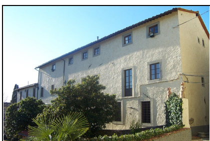
Foto: 13 Data ripresa: 02/02/2006 Edificio: 032 File: 032-13.JPG
