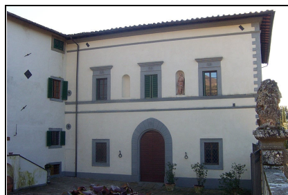
Foto: 06 Data ripresa: 02/02/2006 Edificio: 032 File: 032-06.JPG
