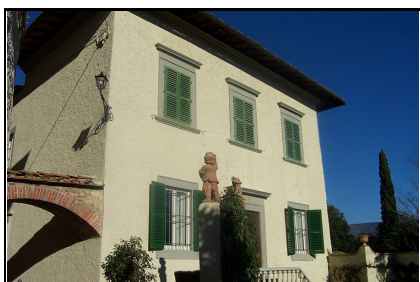
Foto: 10 Data ripresa: 02/02/2006 Edificio: 032/B File: 032-10.JPG
