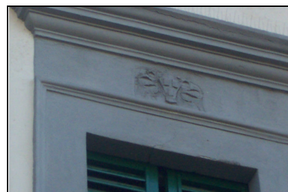
Foto: 30 Data ripresa: 02/02/2006 Edificio: 032 File: 032-30.JPG
