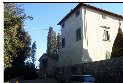
Foto: 33 Data ripresa: 02/02/2006 Edificio: 032/A File: 032-33.JPG
