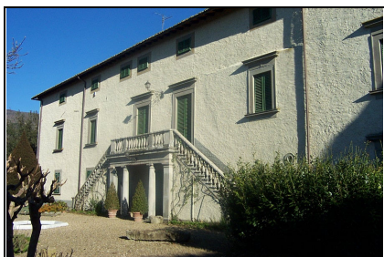
Foto: 01 Data ripresa: 02/02/2006 Edificio: 032/A File: 032-01.JPG
