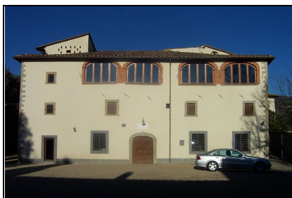
Foto: 02 Data ripresa: 02/02/2006 Edificio: 032 File: 032-02.JPG
