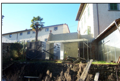
Foto: 14 Data ripresa: 02/02/2006 Edificio: 032/E File: 032-14.JPG
