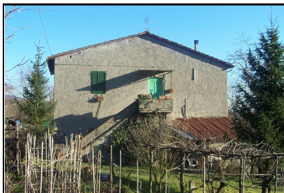
Foto: 08 Data ripresa: 02/02/2006 Edificio: 031/A File: 031-08.JPG
