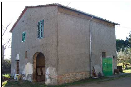
Foto: 07 Data ripresa: 02/02/2006 Edificio: 031/A File: 031-07.JPG
