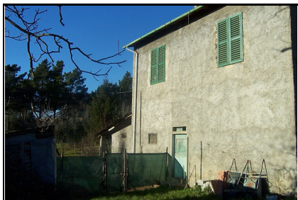
Foto: 10 Data ripresa: 02/02/2006 Edificio: 031/A File: 031-10.JPG
