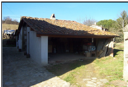
Foto: 11 Data ripresa: 02/02/2006 Edificio: 029/B File: 029-11.JPG
