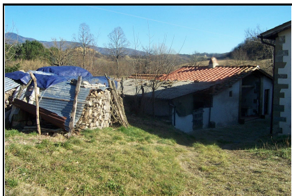
Foto: 07 Data ripresa: 02/02/2006 Edificio: 029/B File: 029-07.JPG
