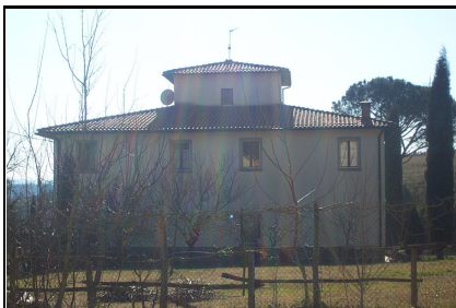
Foto: 10 Data ripresa: 14/02/2006 Edificio: 014 File: 014-10.JPG
