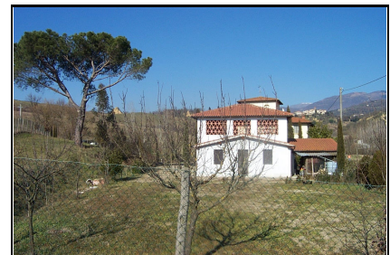
Foto: 12 Data ripresa: 14/02/2006 Edificio: 014/A File: 014-12.JPG
