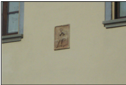
Foto: 04 Data ripresa: 14/02/2006 Edificio: 014 File: 014-04.JPG
