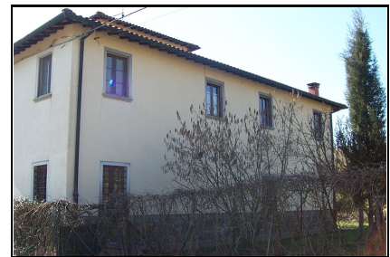
Foto: 09 Data ripresa: 14/02/2006 Edificio: 014 File: 014-09.JPG
