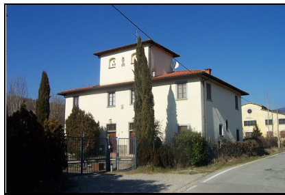
Foto: 02 Data ripresa: 14/02/2006 Edificio: 014 File: 014-02.JPG
