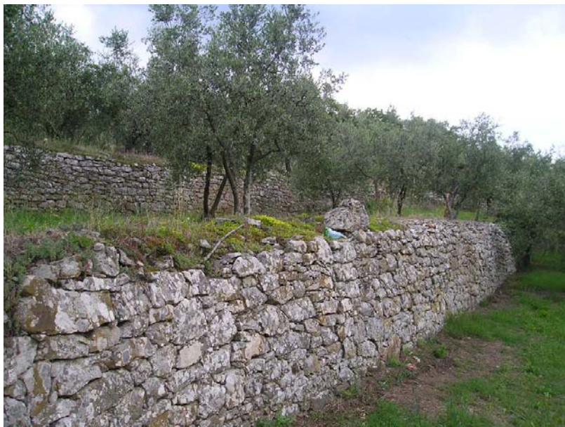
Terrazzamenti in località Rigomagno
