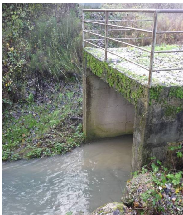
foto 10 – Sbocco tratto tombato F.sso Bolgione (sezione 4)
