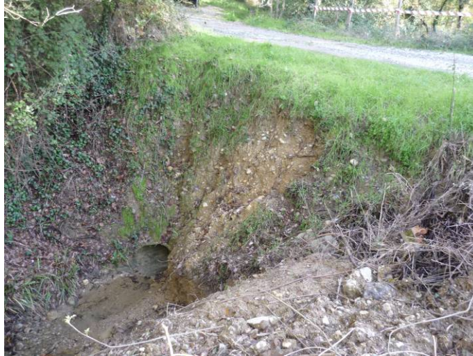
foto 12 – Attraversamento su affluente fosso Bolgione (sezione AF8)
