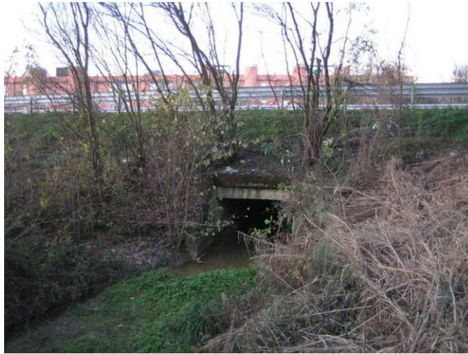
foto 36 –Vista dello sbocco dello scatolare del fosso Borrino a valle del rilevato stradale del raccordo Siena-Bettolle (sezione BO70)
