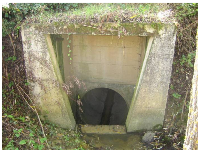
foto 9 – Imbocco tratto tombato a monte di via Aldo Moro (sezione 7)
