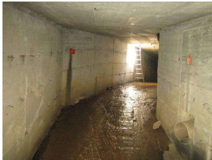
foto 18 –Vista interna tratto tombato (a valle del pozzetto di ispezione nell'area TRAIN)
