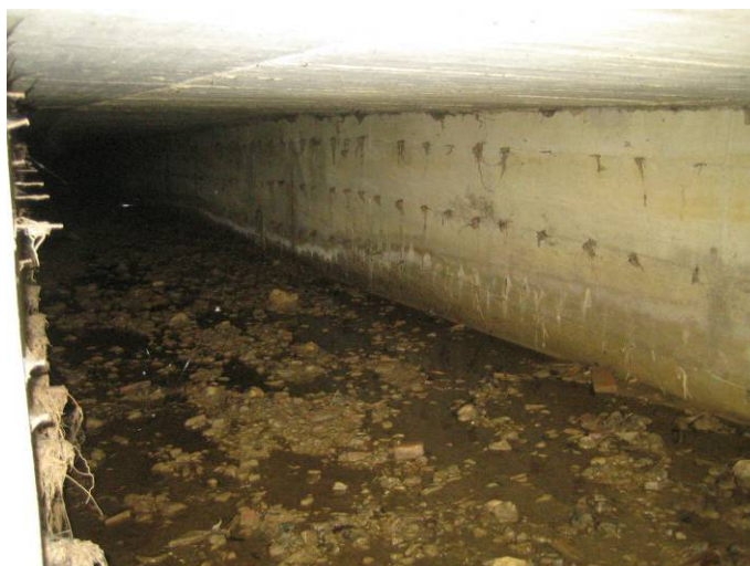
foto 35 –Vista dell'interno dello scatolare del F.sso del Borrino
