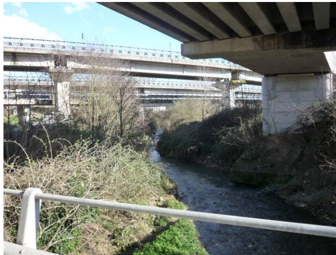
foto 1 – Interferenza fra il torrente e le pile del Viadotto E78 da monte (sezione 405)
