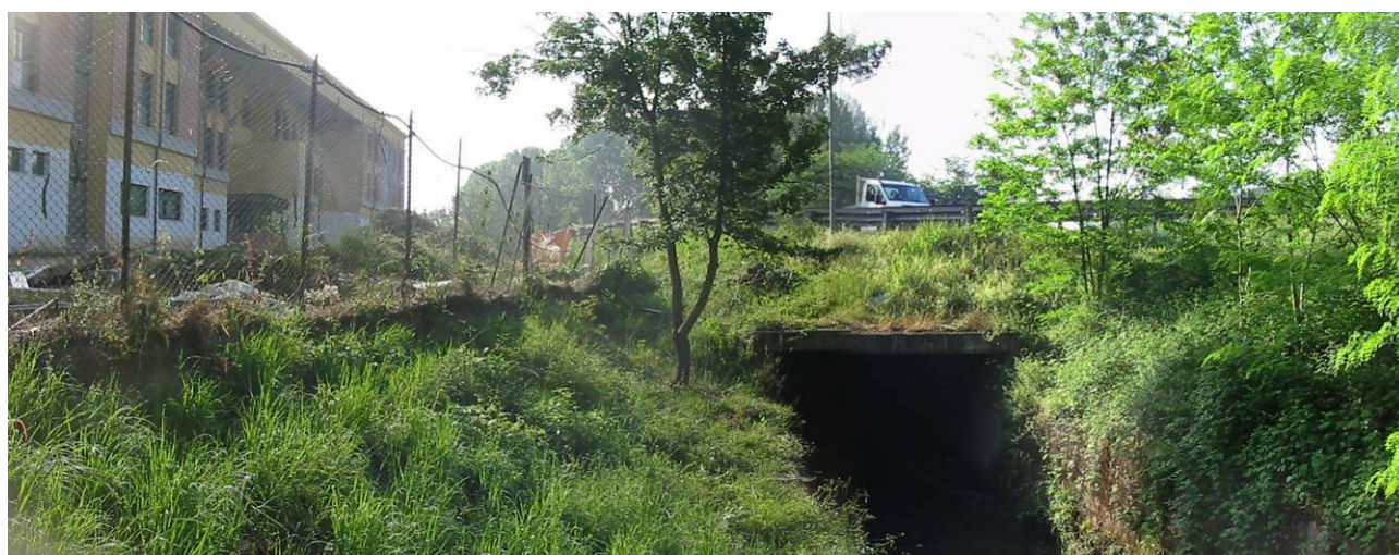
foto 5 – imbocco del tombino in prossimità della nuova caserma dei VVF (sezione 35)
