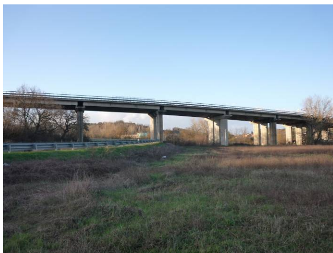
foto 7 – Vista da valle viadotto (sezione 31.5)
