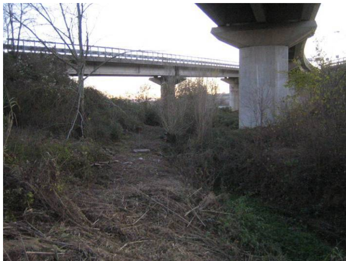
foto 37 –Vista fosso Borrino a valle sbocco scatolare (sezione BO50)
