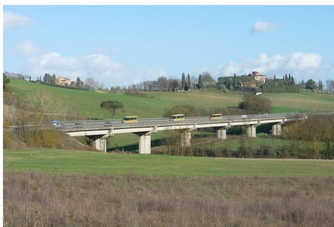
foto 31 –Vista da valle del viadotto del Casone
