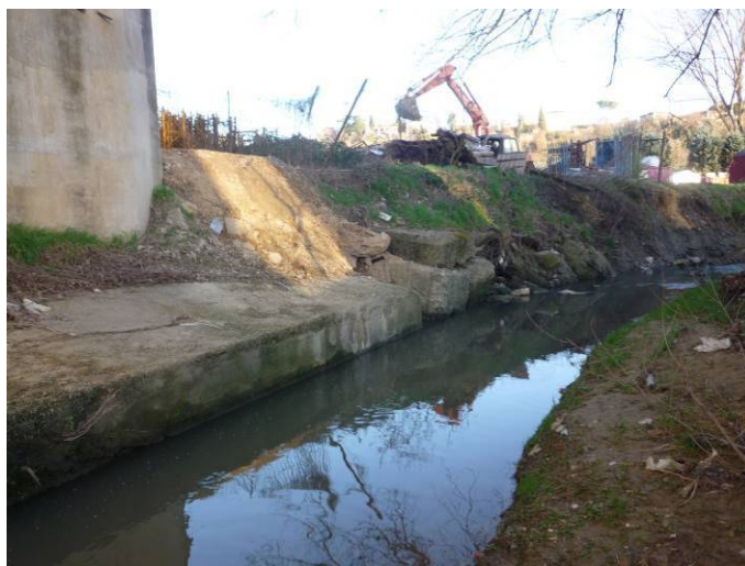
foto 6 – Interferenza pile Viadotto con T. Riluogo (sezione 32.6)
