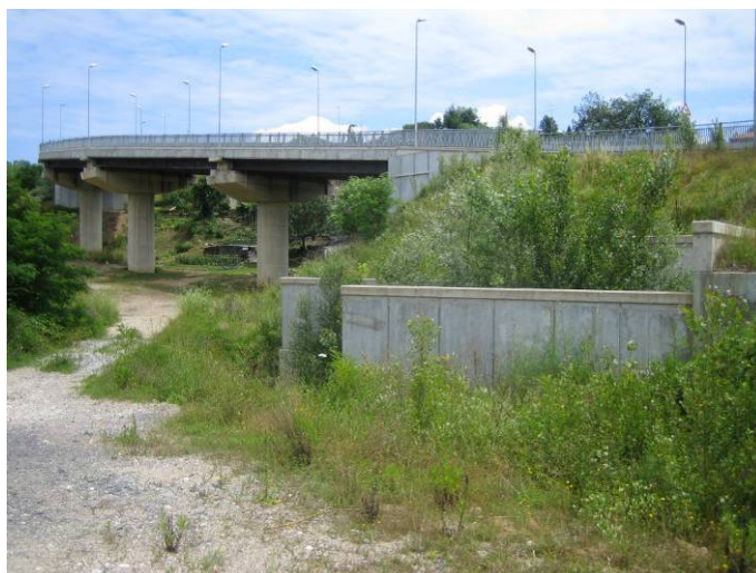
foto 16 –Zona di imbocco del fosso nello scatolare (sezione7)
