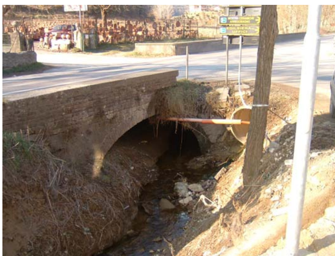
Foto 2 –attraversamento della SS Senese Aretina (sezione SO825)
