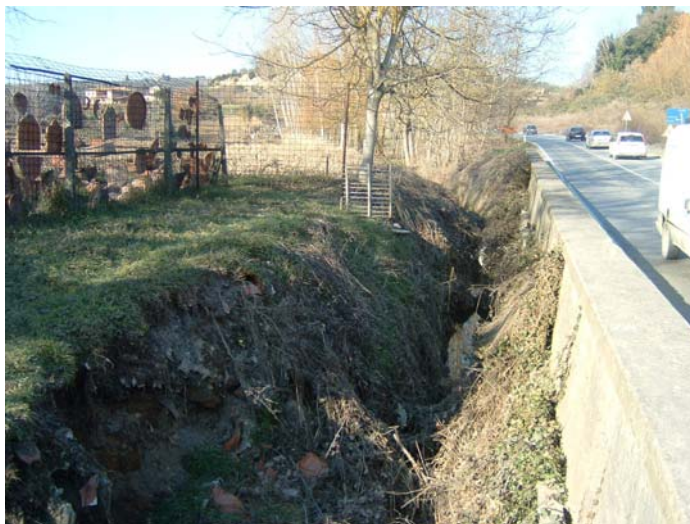
Foto 1 –tratto a monte del attraversamento della SS Senese Aretina (sezione SO900)
