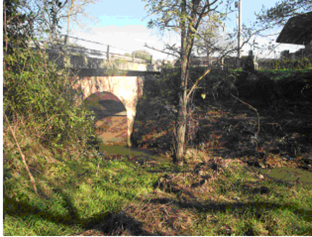
Foto 18 - ponte sul T. Riluogo a valle della confluenza con il T. Ribucciano (sezione RL650)
