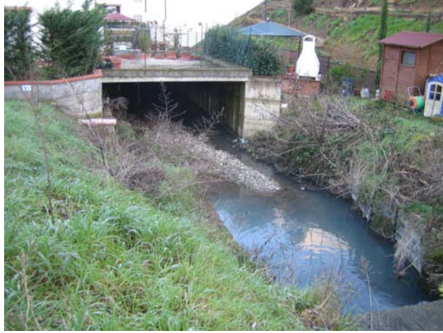
Foto 1 -imbocco del tratto tombato a monte del complesso Ex Socini (sezione 90)
