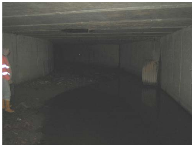
Foto 3 – vista interno tratto tombato (immissione su tratto 56)
