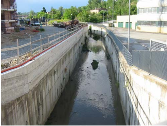
Foto 13 – tratto con sezione rettangolare in calcestruzzo a monte zona Speranza (sezione 43,4)
