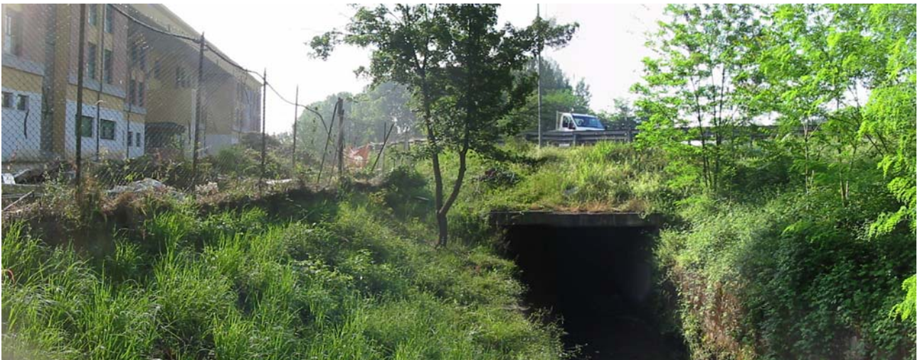
Foto 15 – imbocco del tombino in prossimità della nuova caserma dei VVF (sezione 35)
