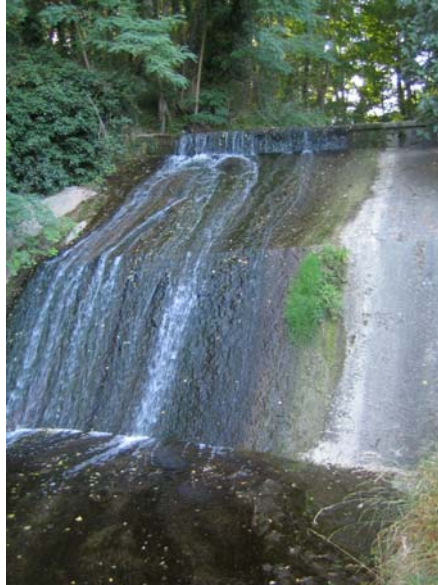
foto 16 - briglia a monte del Molino della Morte a Ruffolo
