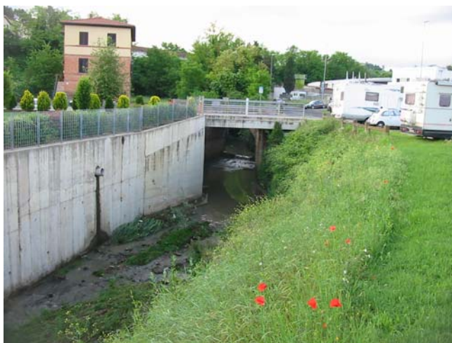
Foto 10 – attraversamento stradale in corrispondenza dell'incrocio con Strada del Casone (sezione 49,25)
