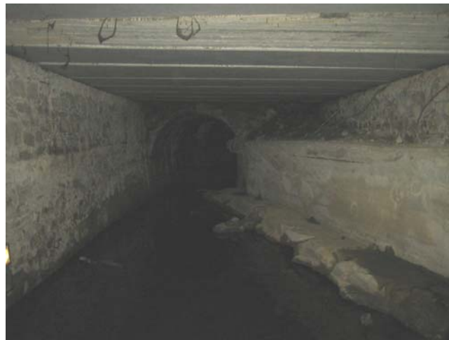
Foto 2 - interno del tratto tombato (transizione tratti 15-14)
