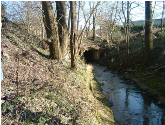
Foto 9 - imbocco del tombino in zona Due Ponti (sezione 52)
