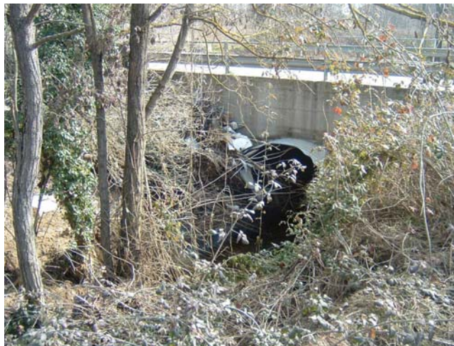
Foto 17 - attraversamento del T. Ribucciano (sezione RB250)
