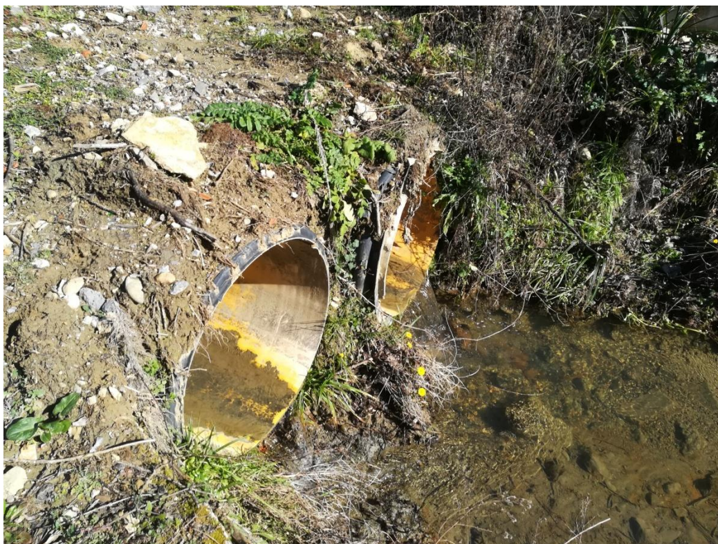
Figura 6.29 - Culvert sul Fosso Paradiso immediatamente a monte dell'attraversamento della Strada di Pieve a Bozzone
