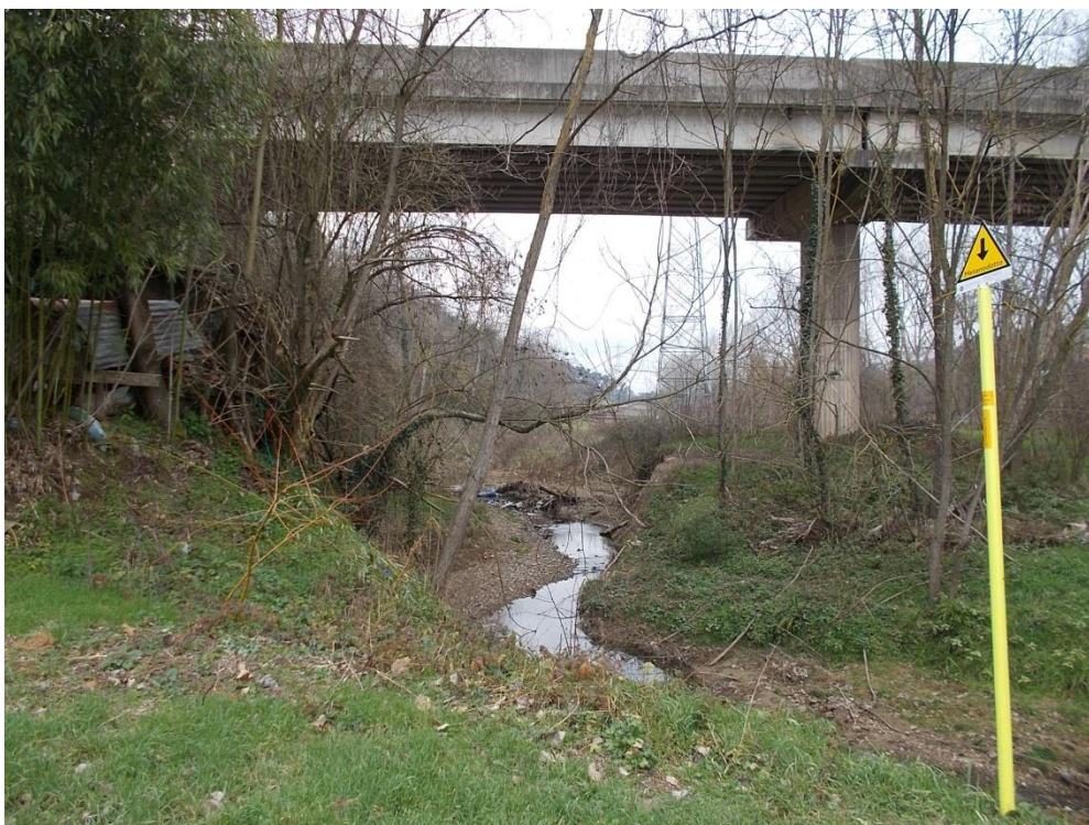
Figura 6.23 - Sotto attraversamento del Tressa sullo svincolo della tangenziale ovest
