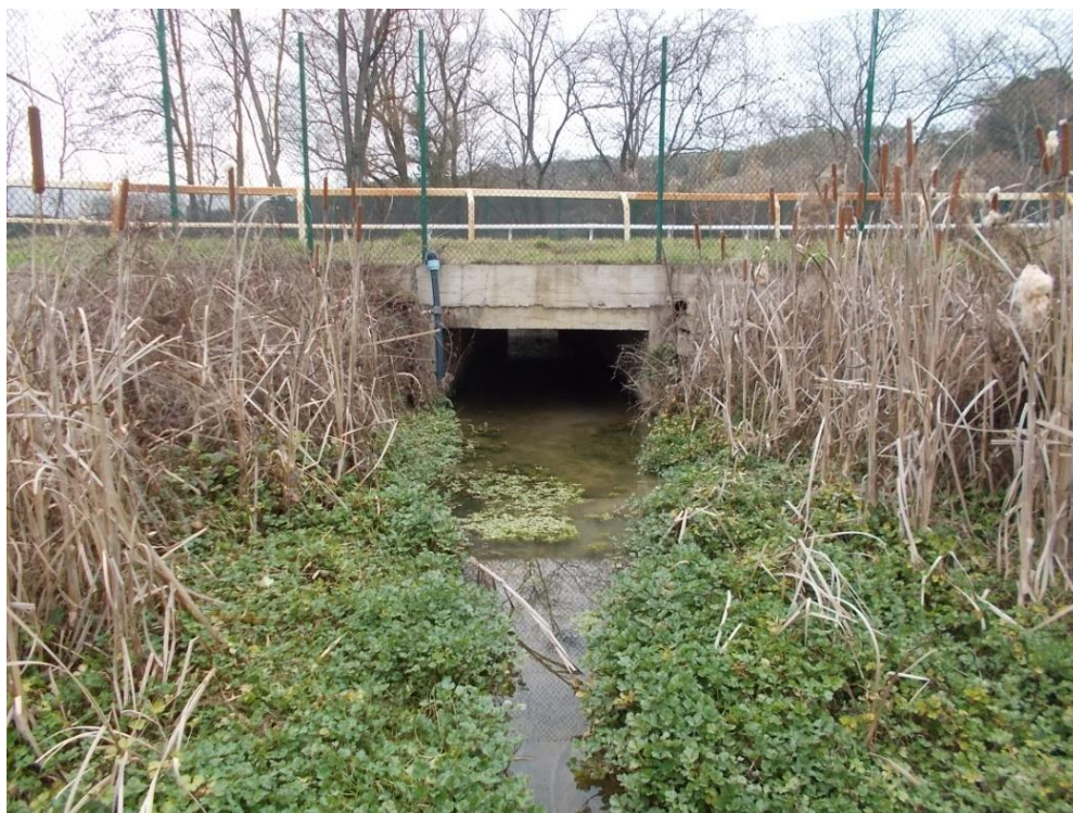
Figura 6.10 - Vista da valle dell'attraversamento dell'ippodromo
