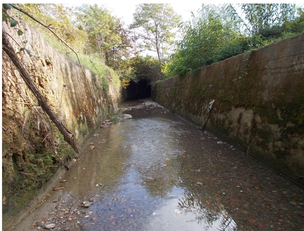
Figura 6.47 - Sezione in uscita tombamento sotto attraversamento zona Vigili del Fuoco
