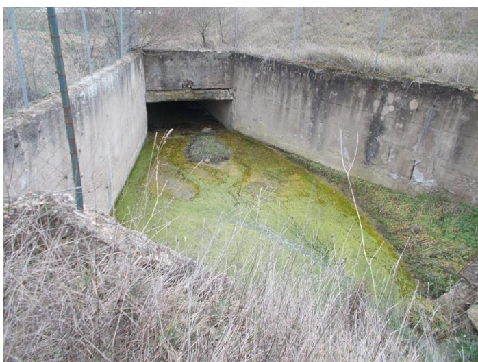
Figura 6.5 - A sinistra sezione inizio tratto tombato e a destra fine tratto tombato del Santa Lucia
