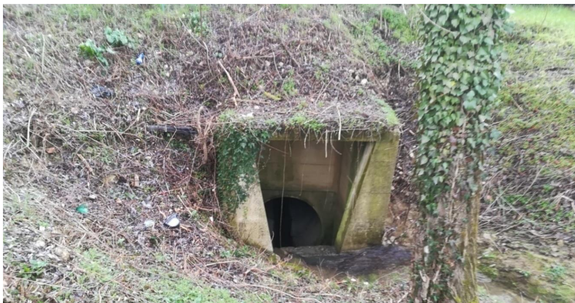
Figura 6.56 - Soglia e inizio tratto tombato del Fosso Castagno
