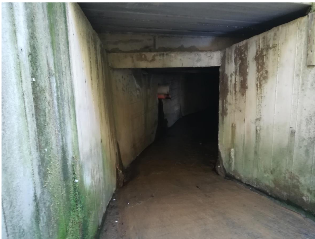
Figura 6.30 - Inizio tratto tombato del F. Paradiso
