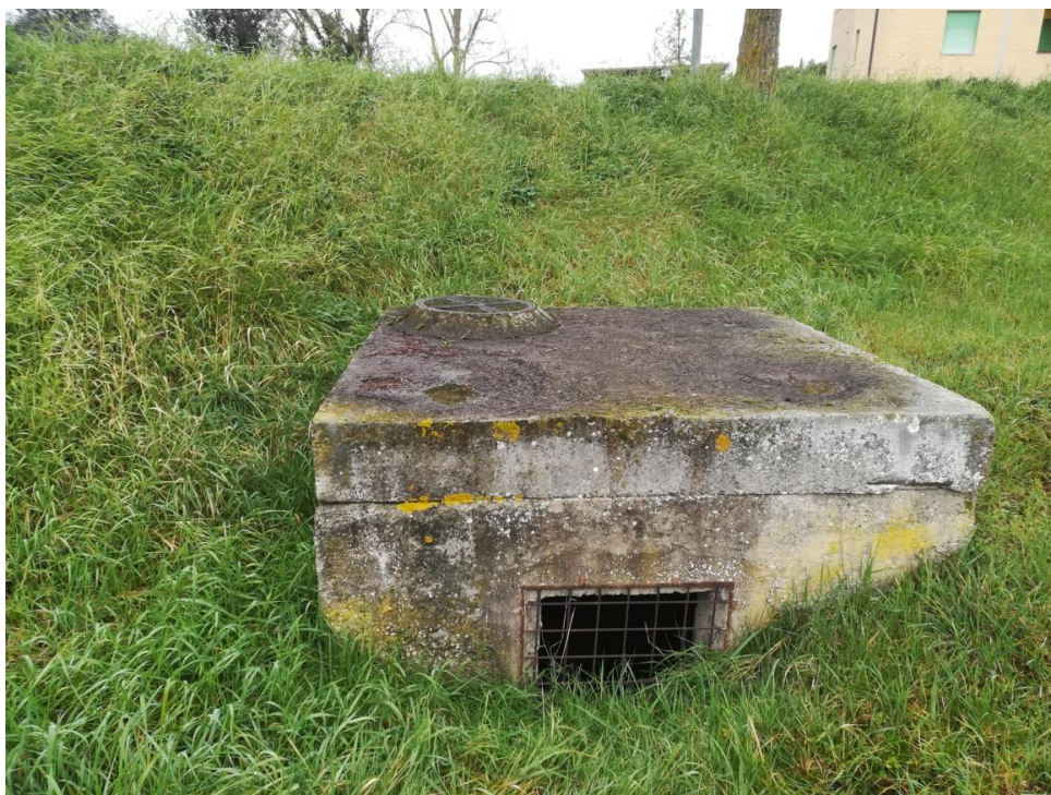
Figura 6.62 - Vista del pozzetto sul tombamento del Castagno da cui provengono i maggiori volumi allaganti
