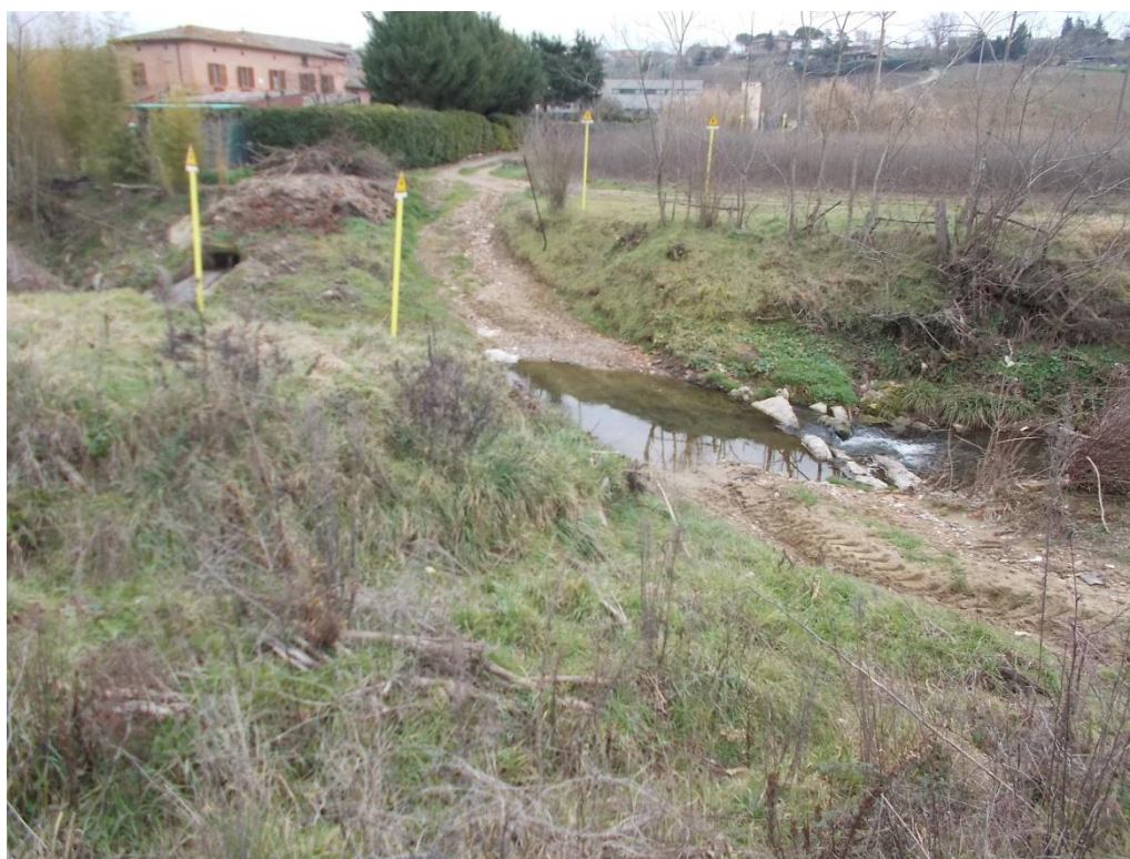
Figura 6.24 - Guado a ruota bagnata in località Cerchiaia
