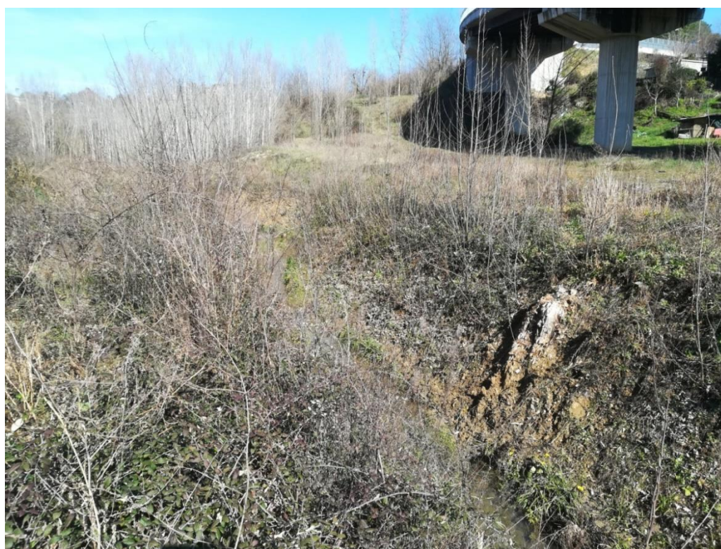
Figura 6.28 - Vista del Fosso Paradiso a monte del culvert
