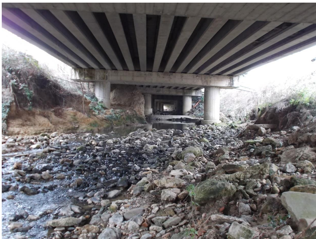
Figura 6.20 - Tratto in cui il Tressa sotto attraversa la tangenziale ovest
