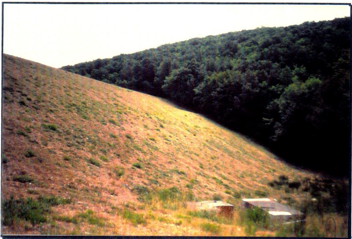
Foto n°2 Paramento di valle della diga in terra.
