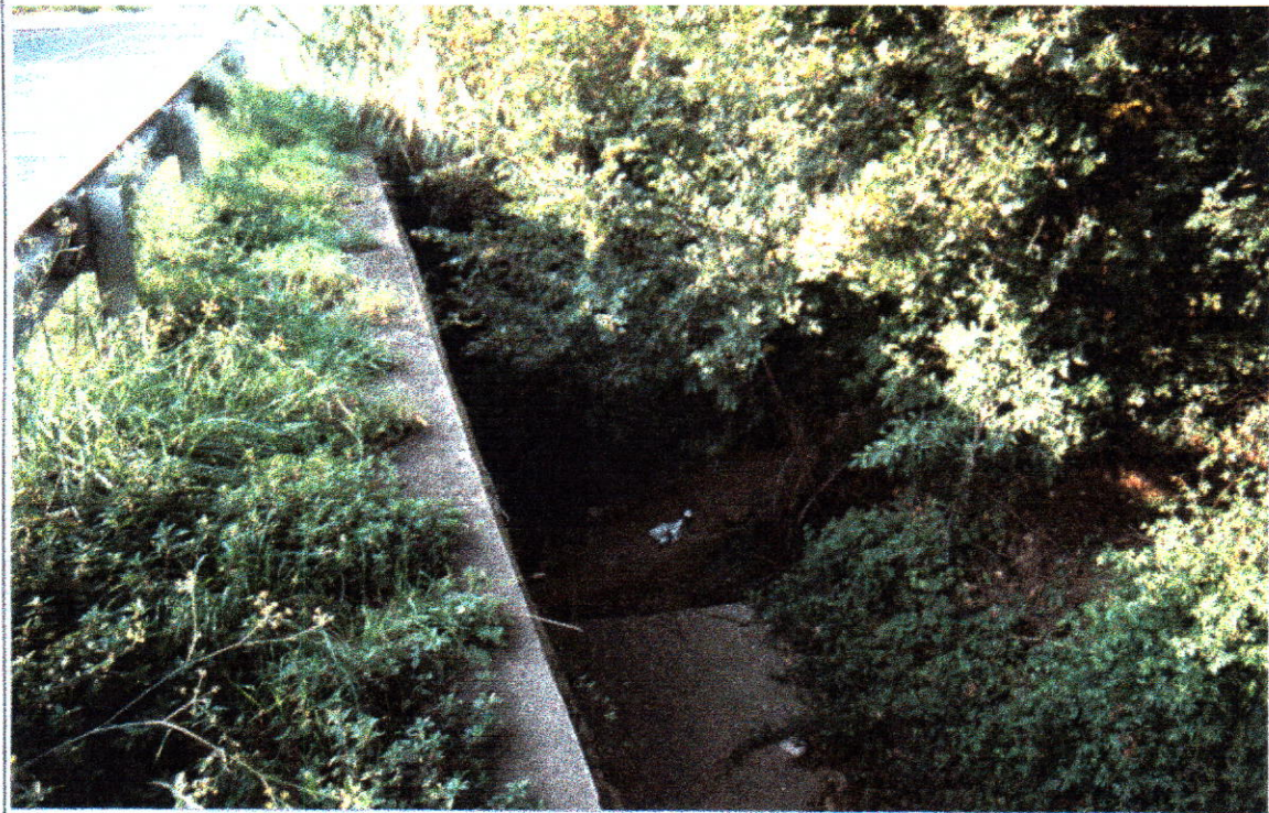
FOSSO VAL DI GORI ALL'ALTEZZA DELL'AURELIA
