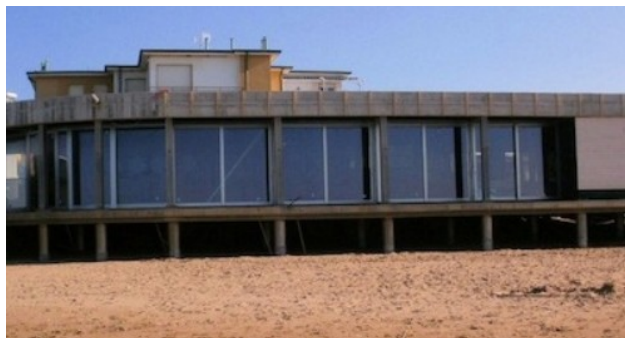
Prima della demolizione
