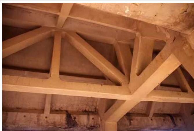
Foto 9: Particolare, di interesse architettonico, capriate in cls armato
