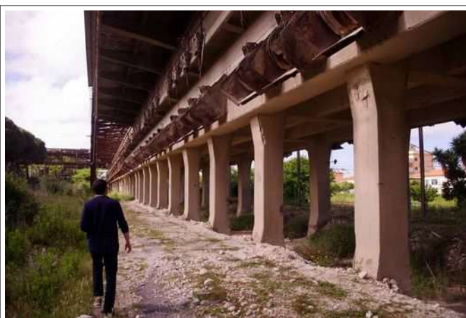
Foto 2: lato est della struttura, con evidenza delle bocche di scarico
