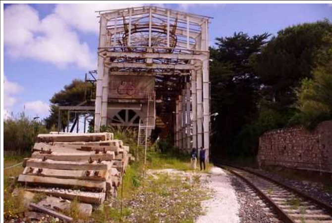
Foto 5: porzione terminale a sud, con traliccio sistema di trazione delle carrucole
