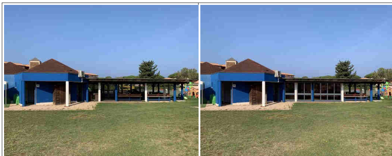
Foto 1: Chiusura spazi esistenti per ampliamento MINICLUB
