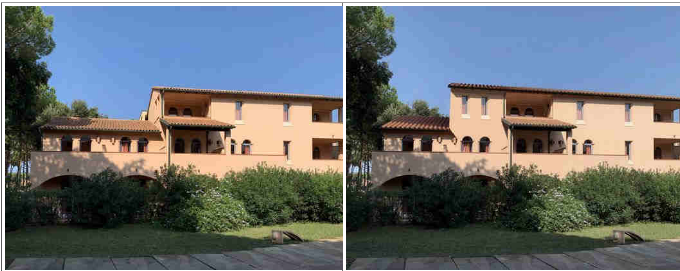
Foto 3: Ampliamento camere tipo A (Tahoma) tramite sopraelevazione
