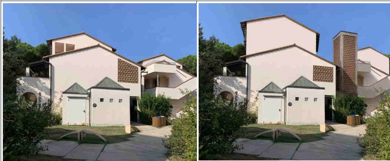
Foto 4: Ampliamento camere con sopraelevazione e realizzazione torre ascensore (Nymphaea)
