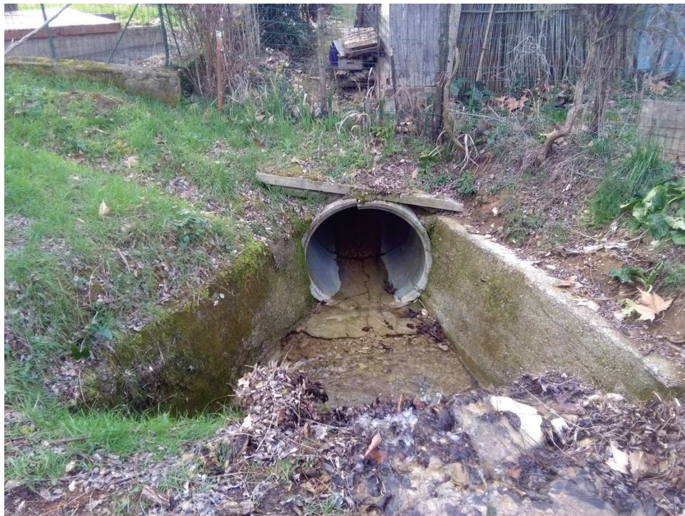
Figura 3: Imbocco del tratto tombato del Rio di Fonte Spugnoli.
