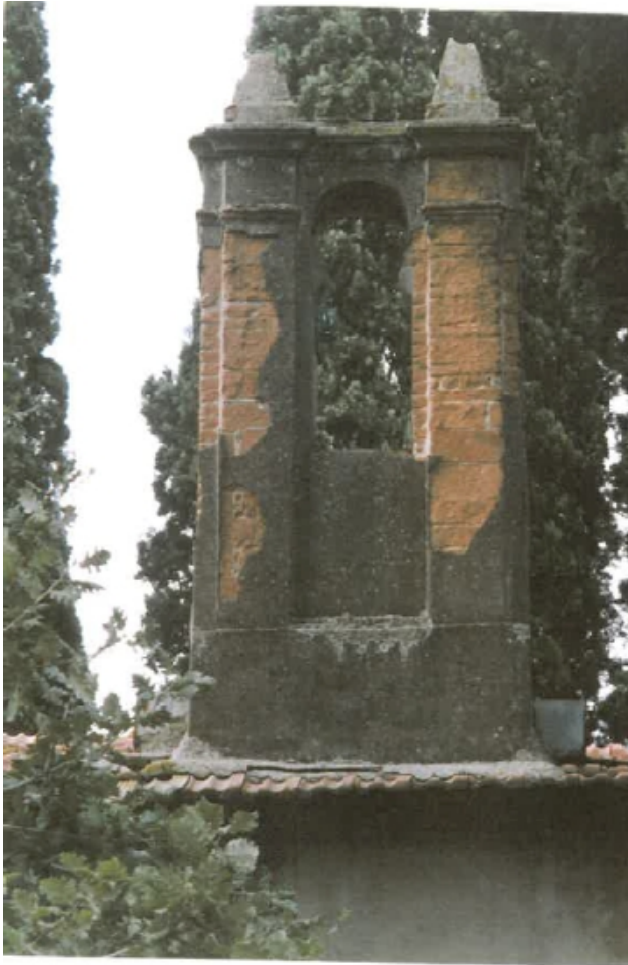
Foto allegate alla Aut. Edilizia n.90/2001 – pre intervento
