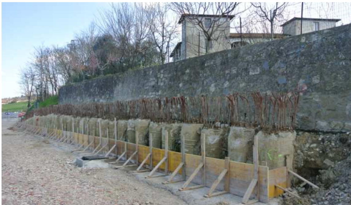
Dettaglio dell'opera di consolidamento realizzata dalla Regione Toscana nel novero dei lavori di adeguamento della S.P. n. 69 (paratia di in pali trivellati diam. 800 mm – lunghezza 11.0 ml)
