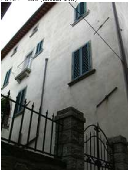
Categoria: Caratteristiche architettoniche e strutturali
