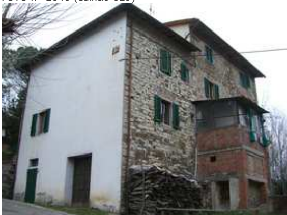
Categoria: Degrado architettonico/incongruità
