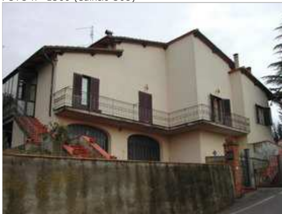
Categoria: Degrado architettonico/incongruità
