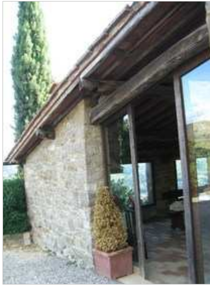
Categoria: Edificio FOTO n° 4376 (edificato minore 696)
