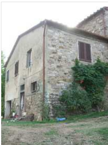
Categoria: Edificio FOTO n° 3949 (edificio 1034)
