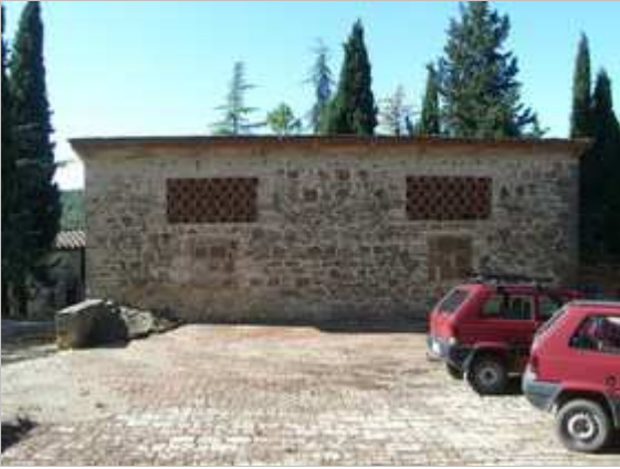
Categoria: Edificio FOTO n° 4118 (edificato minore 611)
