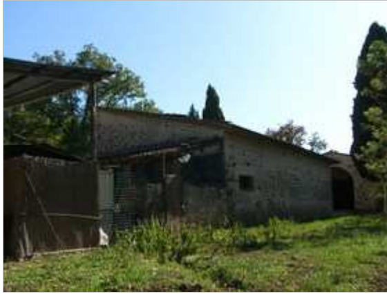
Categoria: Edificio FOTO n° 4119 (edificato minore 612)
