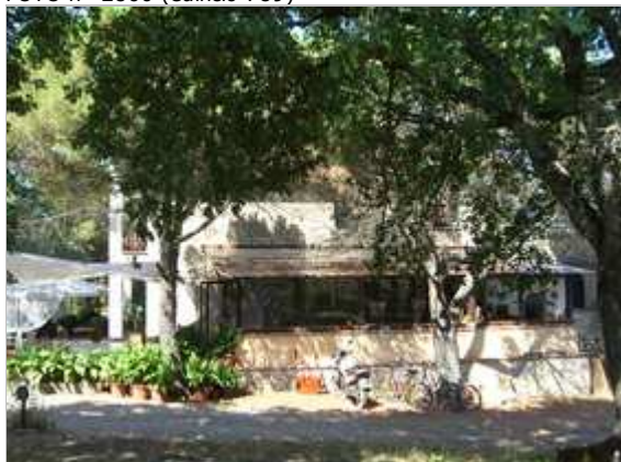
Categoria: Degrado architettonico/incongruità
