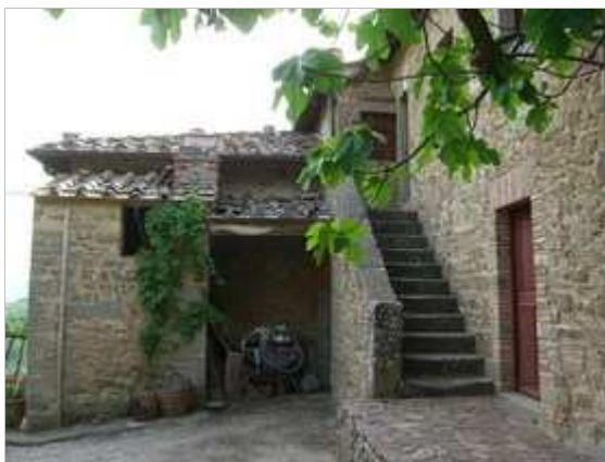
Categoria: Edificio FOTO n° 1949 (edificato minore 302)
