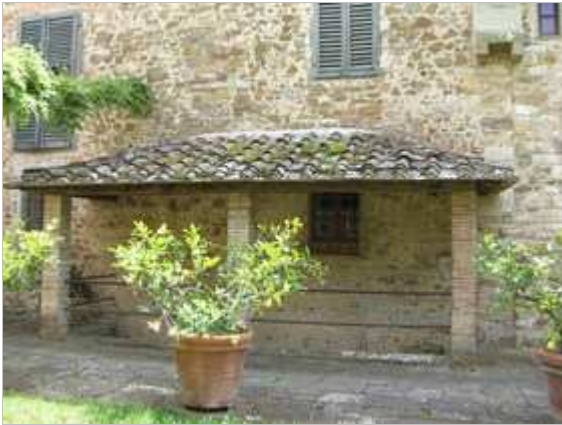
Categoria: Edificio FOTO n° 1877 (edificio 585)
