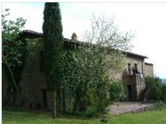
Categoria: Edificio FOTO n° 1977 (edificio 616)
