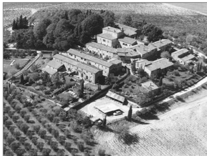
Figura 79 - vista aerea lato Est
