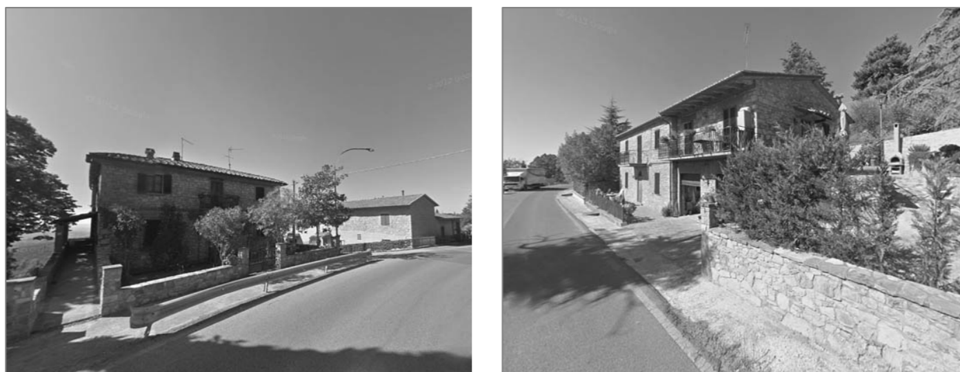
Figura 97- Da sinistra a destra: Fioraie vista da Est (arrivando da Castellina in Chianti) lato strada sinistro e lato strada destro
