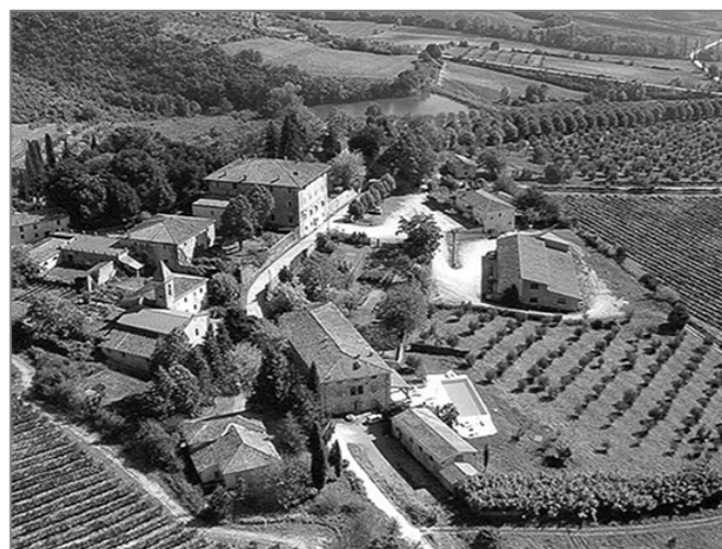
Figura 85 - vista aerea lato Nord
