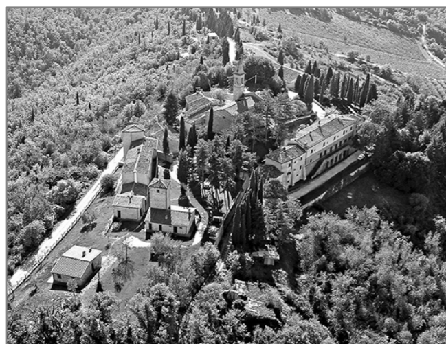
Figura 55 - vista aerea lato Sud/Est
