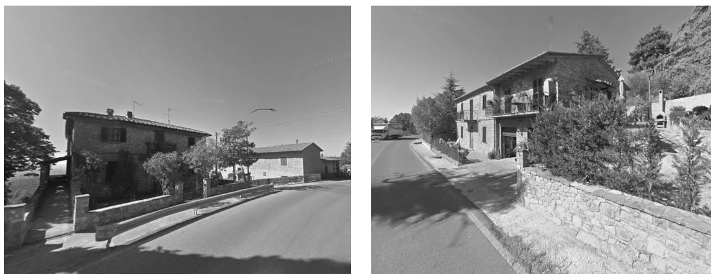
Figura 21 - Da sinistra a destra: Fioraie vista da Est (arrivando da Castellina in Chianti) lato strada sinistro e lato strada destro
