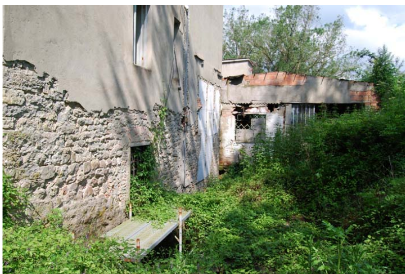
Particolare della porzione della parete a contatto con l'invaso d'acqua presente, ma coperto dalla vegetazione e senza una visibile entrata ed uscita del flusso
