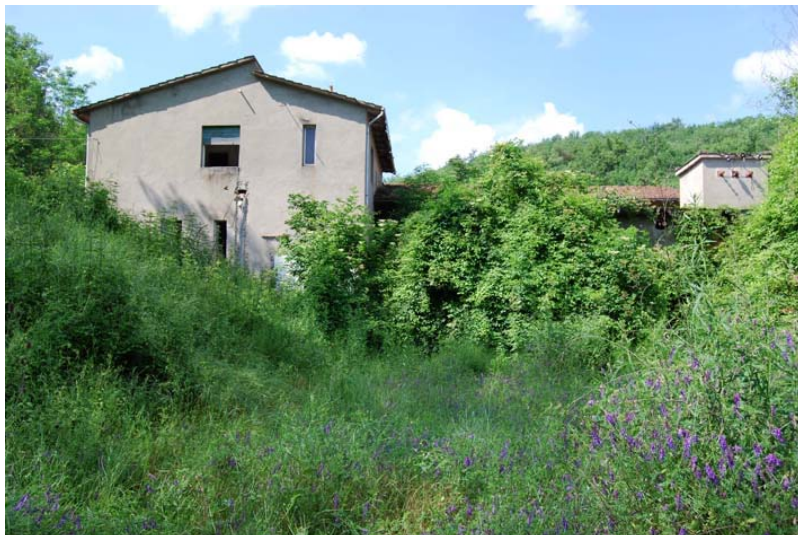
Vista del complesso da nord.
