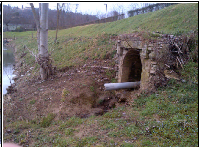
SCARICO 3 – \Phi arco=100 cm, H tratto vert.=70 cm, H base=100,99 m s.l.m.
