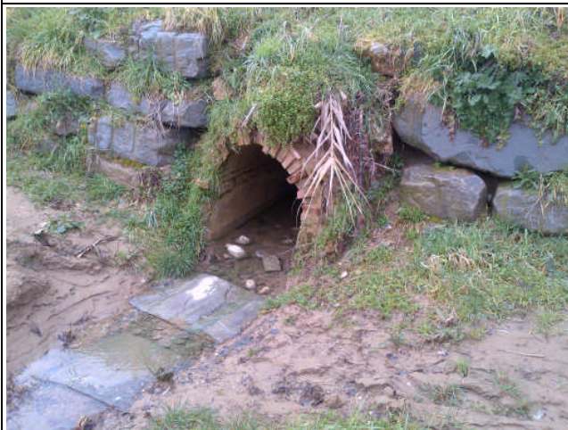
SCARICO 4 – \Phi arco=90 cm, H tratto vert.=60 cm, H base=101,46 m s.l.m.
