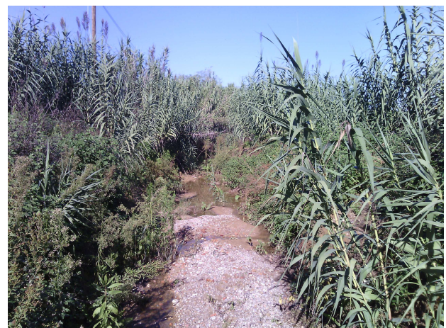
Alveo di MV46433 a valle della Variante SR2
