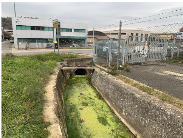
Imbocco tombamento su SP1 in adiacenza a impianto ENEL del fosso MV45059, vista verso valle
