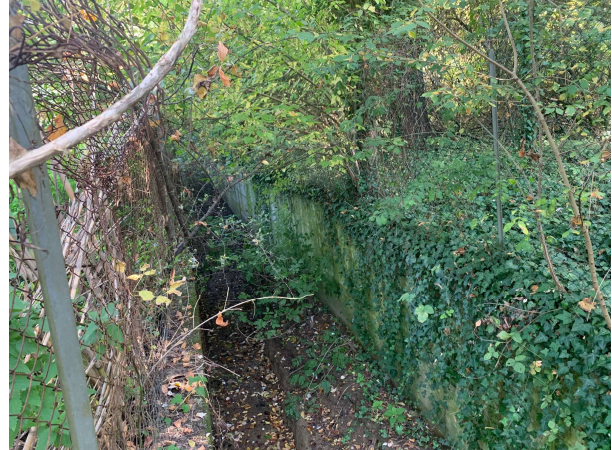
Alveo a cielo aperto tra muri di sponda in c.a. a valle del raccordo FI-SI
