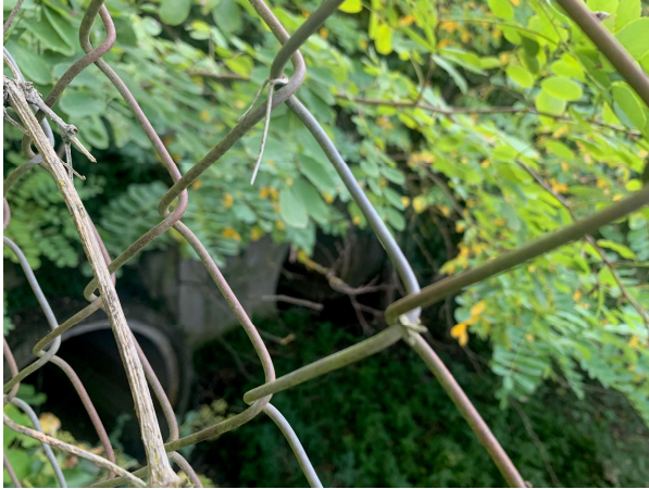
Doppia canna di attraversamento del raccordo FI-SI, lato di valle
