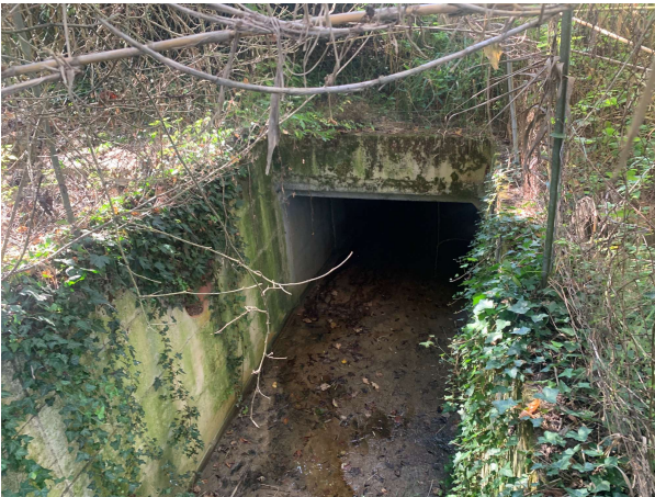
Imbocco del tombamento
