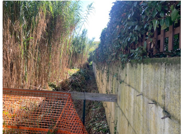
Alveo di MV46433 a valle della confluenza con MV46531, appena prima del tombamento
