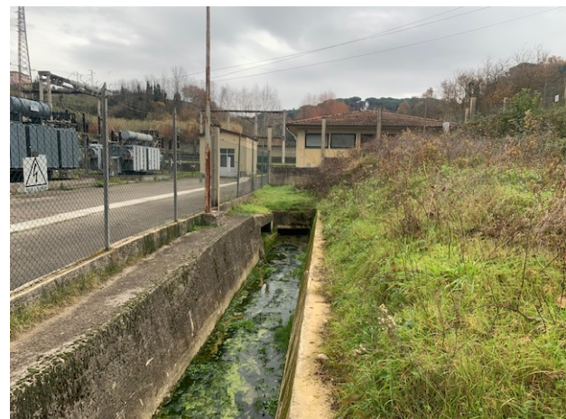
Canalizzazione di MV45059 in uscita dal primo tombamento all'interno dell'impianto ENEL, vista verso monte
