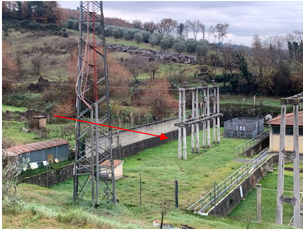
Panoramica della parte tergaie dell'impianto ENEL, con indicazione del punto di arrivo del fossato MV45059
