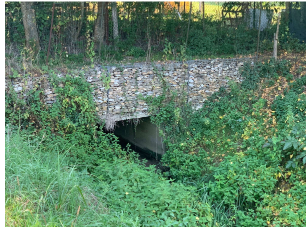
Sbocco del tombamento
