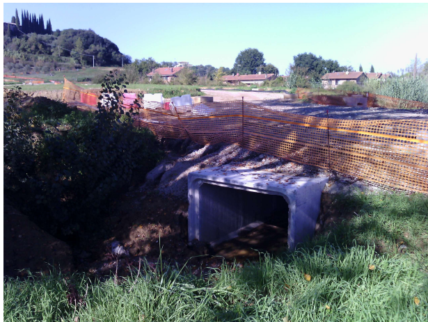
Nuovo attraversamento di MV46433 su Variante SR2
