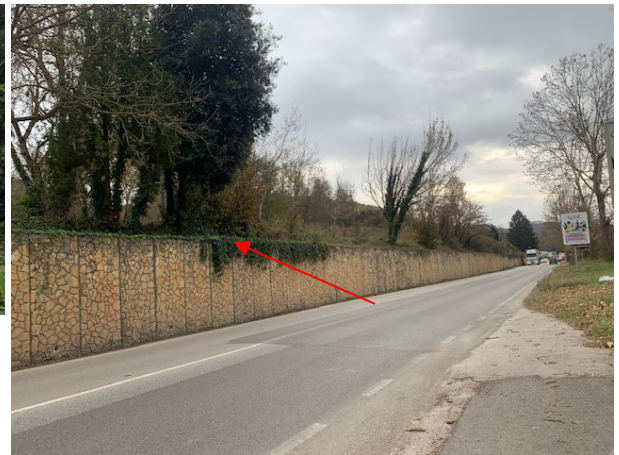
Muro di sostegno lungo la SP1 da cui, presumibilmente, dovrebbe giungere il fosso MV45144
