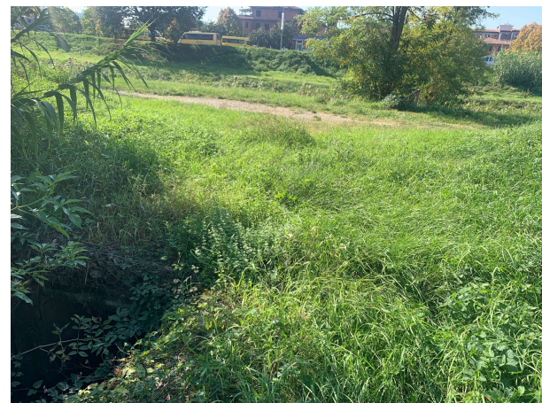
Culvert sotto la banca appena a monte della confluenza col T. Staggia
