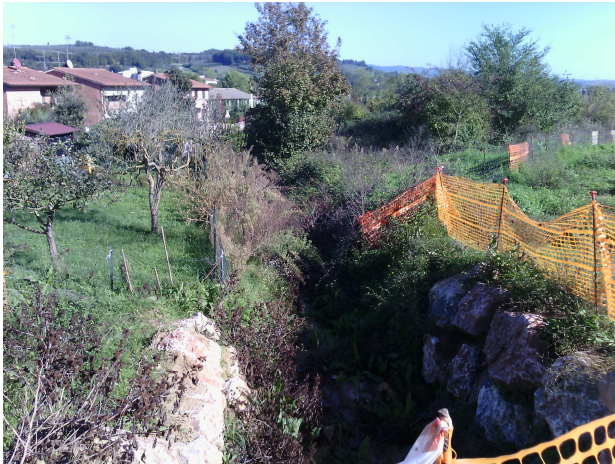
Alveo di MV46531 a valle della Variante SR2
