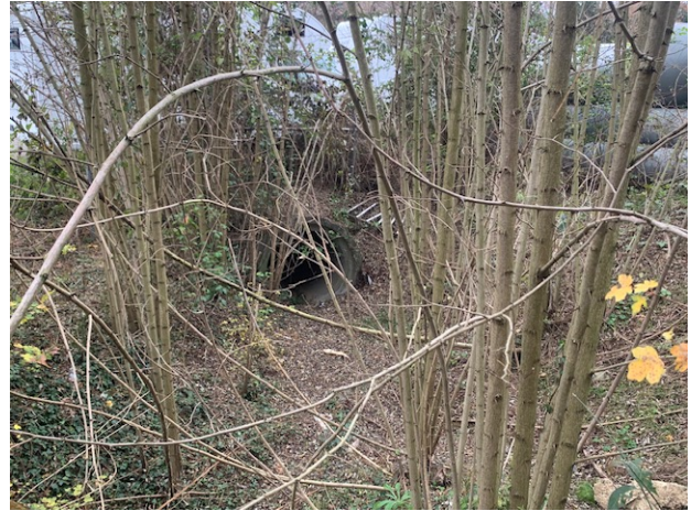
Prima tubazione lungo MV45184 all'altezza del parcheggio dei camper, vista verso valle
