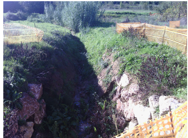
Alveo di MV46531 a monte dell'attraversamento su Variante SR2
