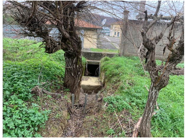
Imbocco del primo tombamento su fossato MV45059 in corrispondenza dell'impianto ENEL, vista verso valle
