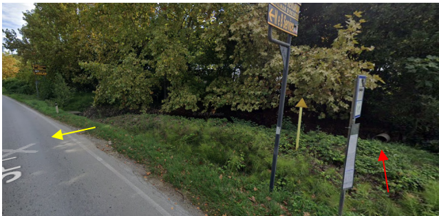
Arrivo del fosso MV45184 sulla SP1 (freccia rossa) ed inizio del tratto tombato di valle (freccia gialla)
