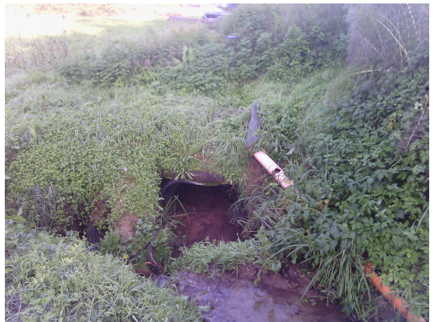
Imbocco del tombamento su fosso MV46471
