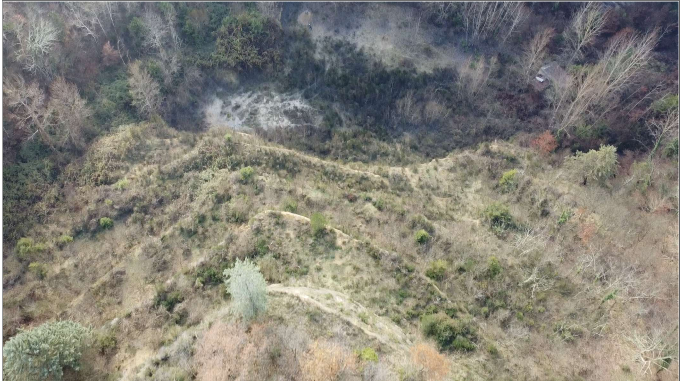
Figura 6 - Area del sito estrattivo dismesso RT0001543 sito in località Lisoia su immagine scattata con drone DJI Mini 2. Vista zenitale del fronte gradonato e del sottostante piazzale in cui si può osservare anche la presenza di un manufatto.
