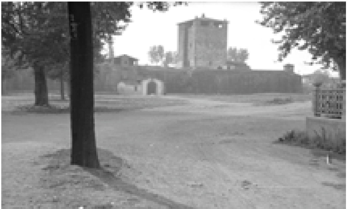
Progetto di apertura delle mura a fianco di Porta Carratica e veduta della porta dopo i lavori di demolizione nel 1912.
