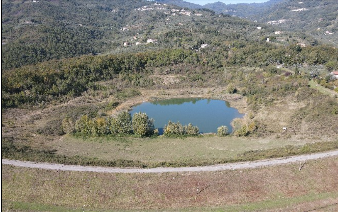
Figura 0.5 - Vista del paramento della diga e dell'invaso (vista da SE), foto da drone
