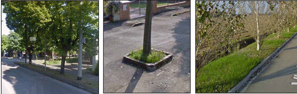
Esempi di aree verdi stradali delimitate da cordoli chiusi
