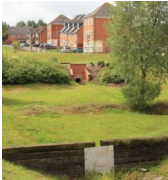
Bacino di detenzione
