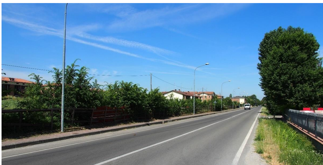
Fig. 26: Via Provinciale Est – qualità complessiva buona
