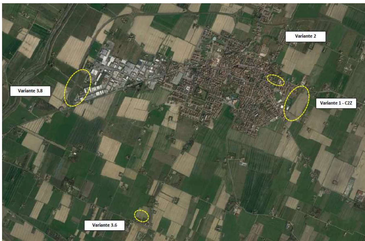
Figura 1: Ubicazione delle aree interessate alle varianti di PRG su base fotografia satellitare (fonte: Google Earth)
