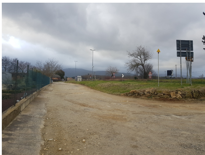
lo stabilimento oggetto di ampliamento con l'intervento AT4.08 e gli spazi esterni da riqualificare
