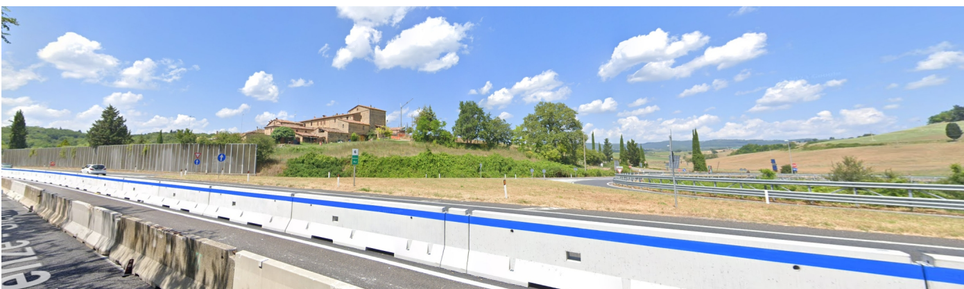
Vista dal Raccordo Siena-Firenze (da Google Streetview)
