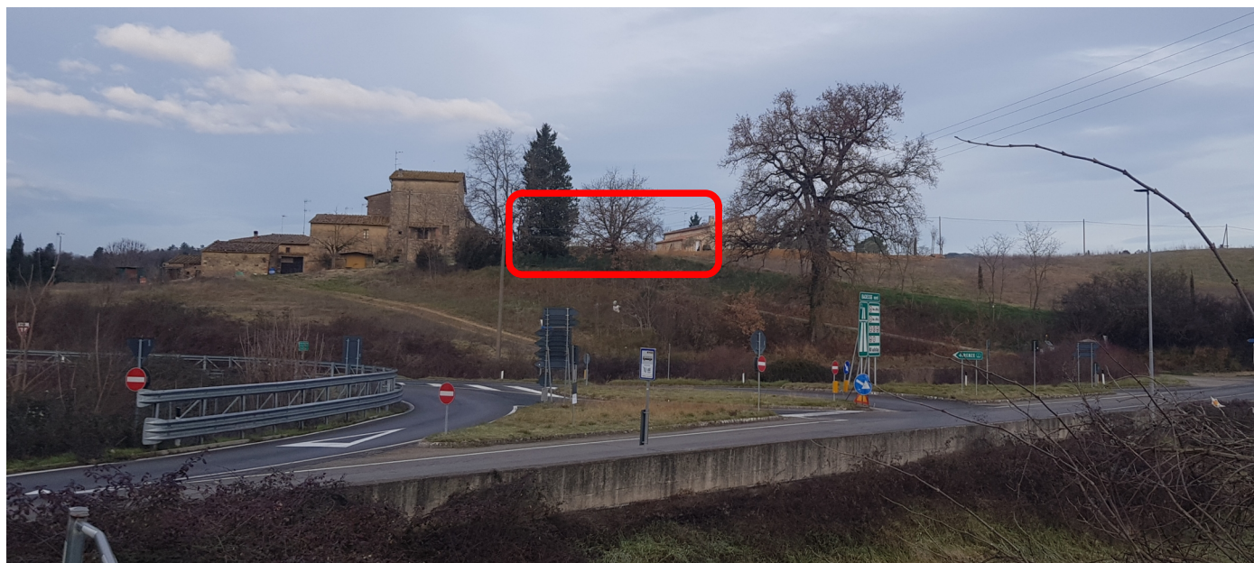
vista dell'aggregato da sud con la localizzazione del parcheggio
