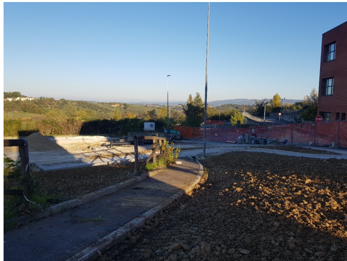
foto del cantiere a novembre 2024
