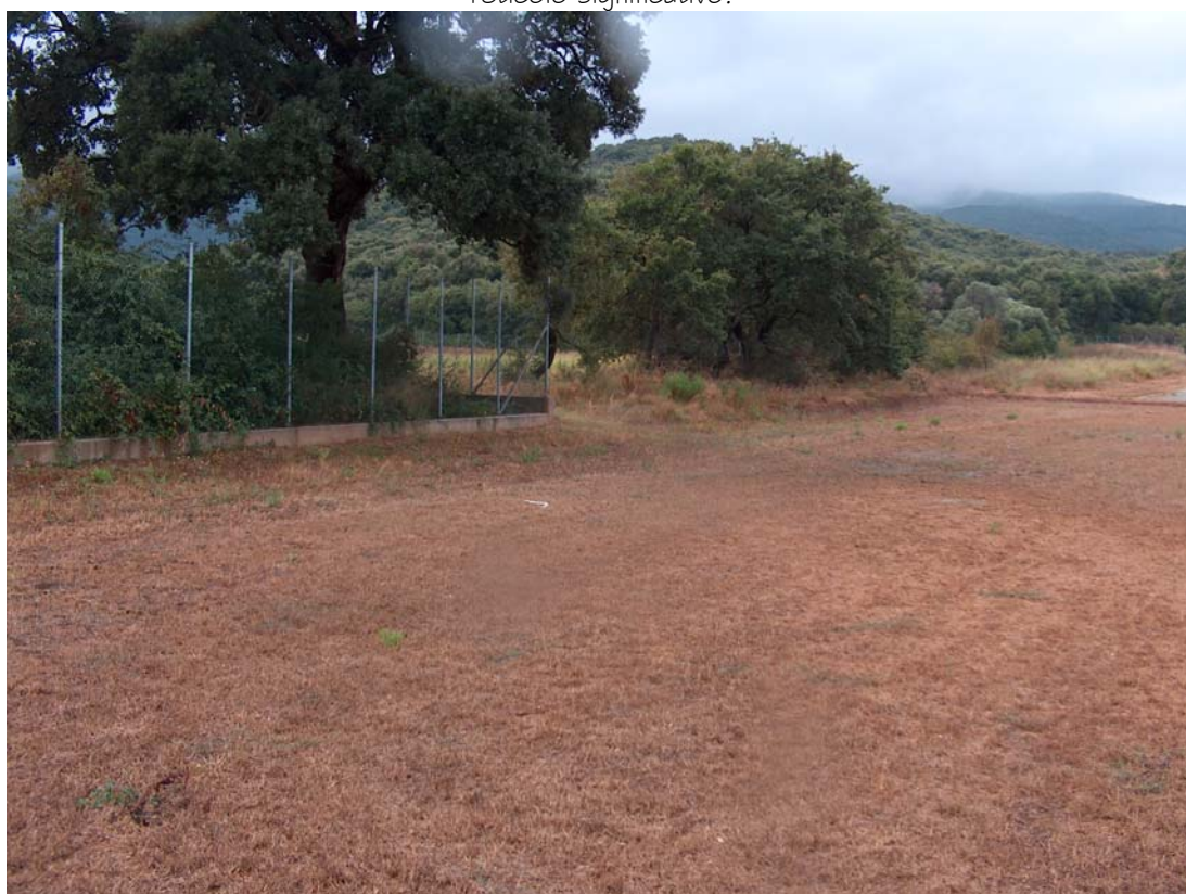
Parte a monte dell'impianto sportivo dove dovrebbe essere il orso d'acqua individuato dal P.A.I.. Sulla sinistra si vede la nuova sistemazione idraulica dell'area con la formazione di nuove cunette.
