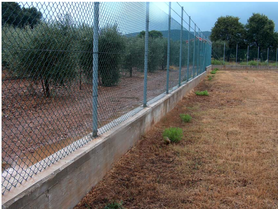
Vista del limite dell'area dell'impianto sportivo che dovrebbe essere il tracciato del fosso riportato nel reticolo significativo.
