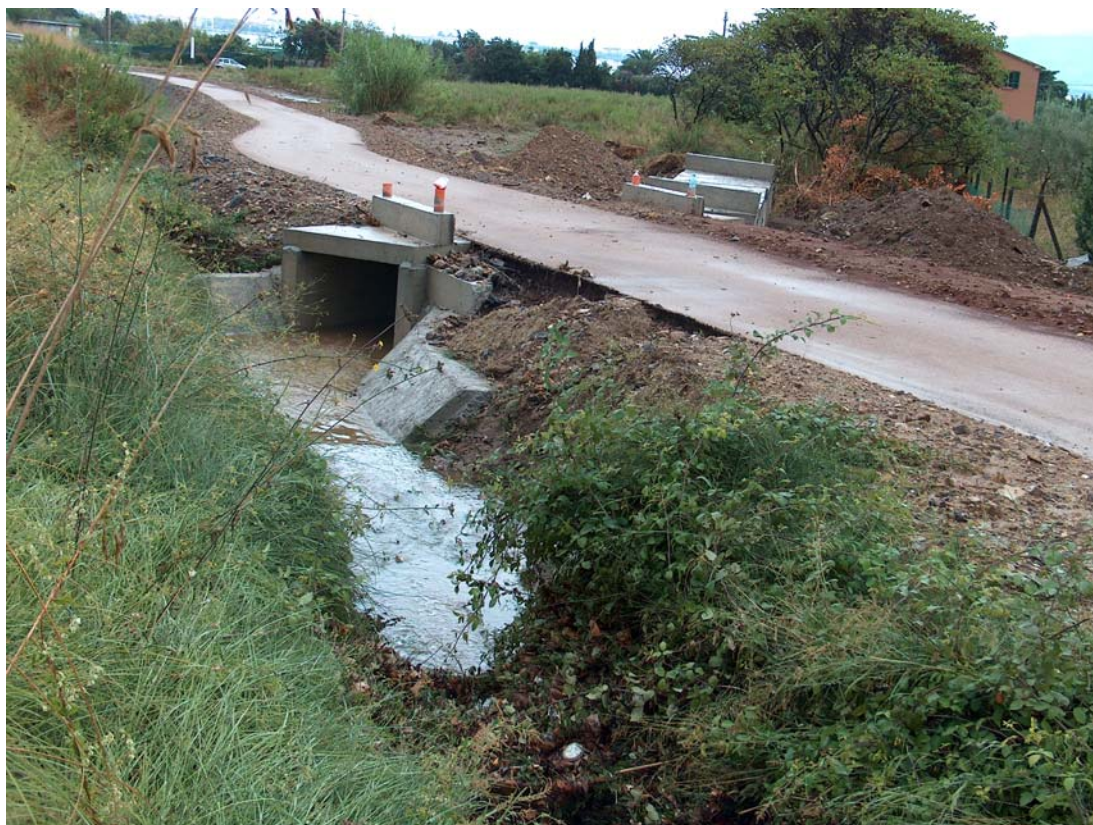
Vista del rilevato sul lato sinistro del corso d'acqua che determina come l'eventuale rischio idraulico riguarda esclusivamente la sponda destra che risulta evidentemente più basso.
