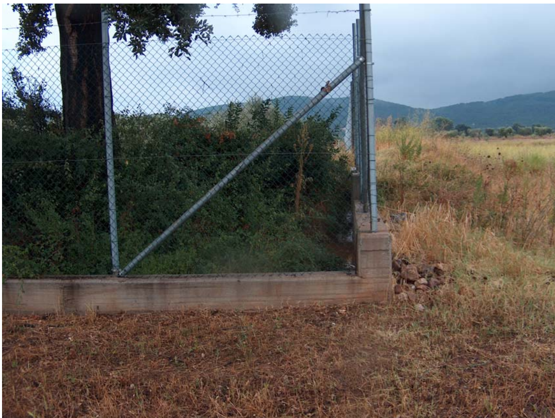
Particolare delle condizioni in un punto dove la cartografia P.A.I. riporta il corso d'acqua indicato come significativo.
