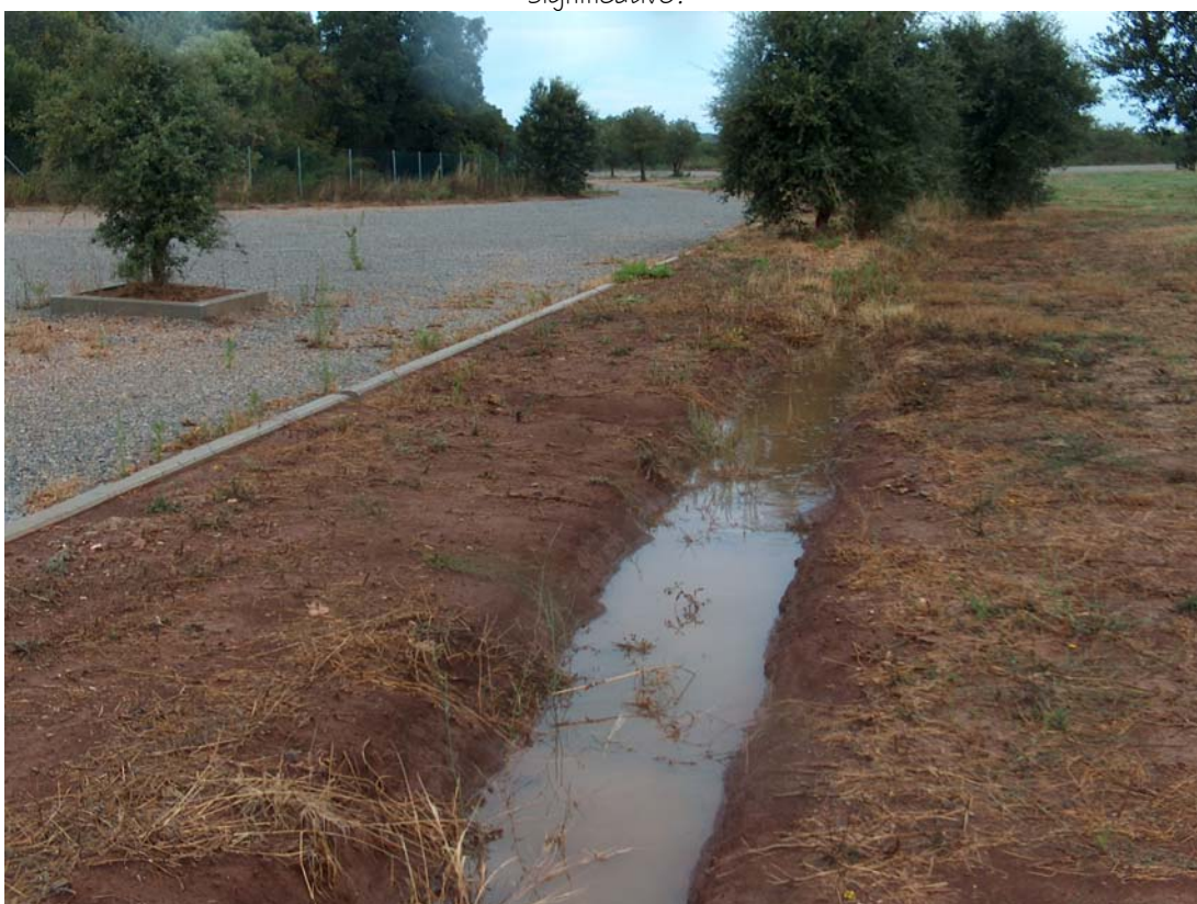
Particolare della nuova sistemazione idraulica all'interno dell'impianto sportivo.
