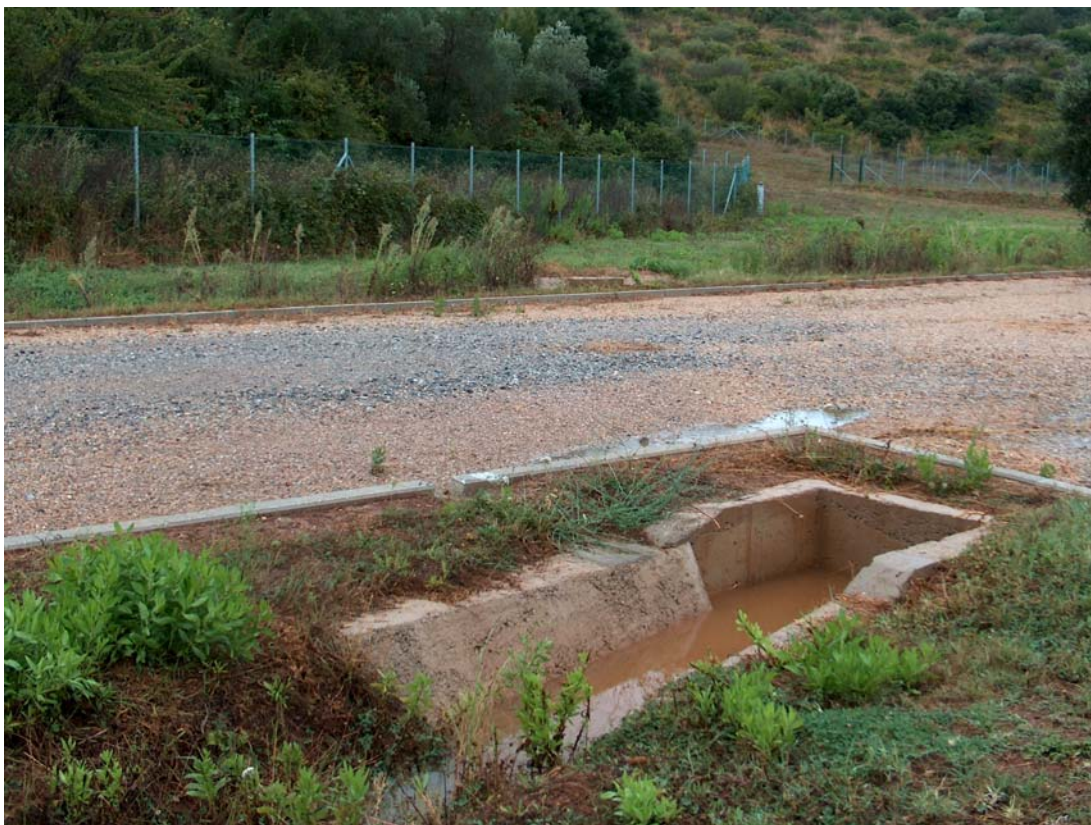
Opere d'arte relative alla regimazione idraulica all'interno dell'impianto
