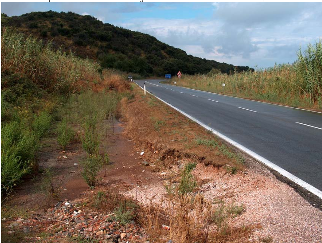
Vista della S.S. n. 440 di Porto Santo Stefano dove si vede la posizione di uscita della regimazione idraulica interna all'impianto sportivo (dove si vedono i cartelli stradali), in una posizione completamente diversa a quella indicata nella cartografia P.A.I.
