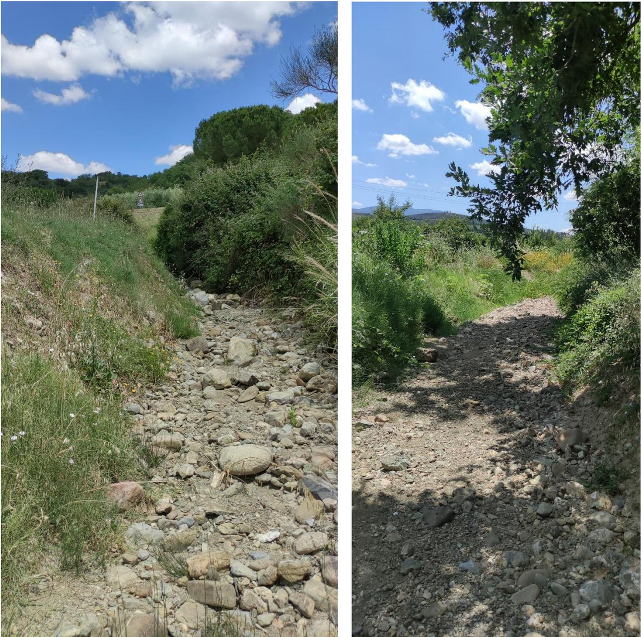
**Figura 7-43** – documentazione fotografica del fosso TS78736 nel tratto oggetto di studio: a sinistra, prima del lungo tombamento; a destra dopo il tombamento a valle della ferrovia
