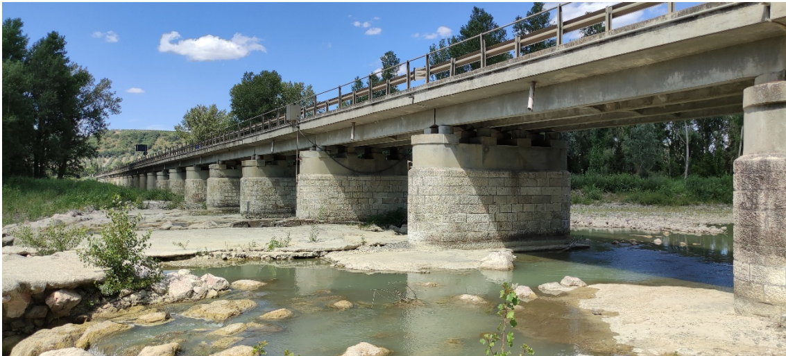
Figura 7-22 – Attraversamento sul Fiume Orcia
