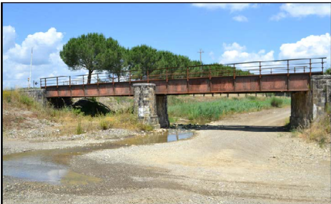
Figura 7-21 - Attraversamento ferroviario sul Torrente Spagnola
