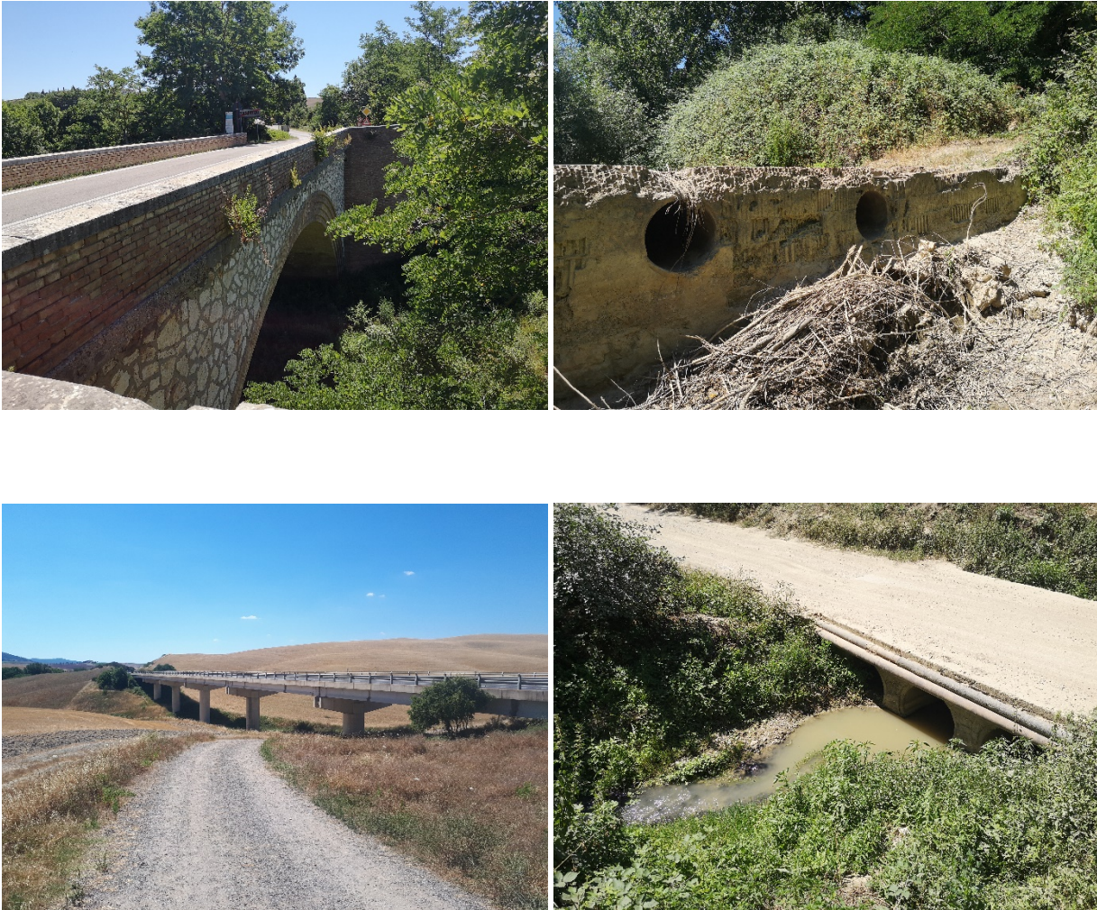
Figura 7-4 – Attraversamenti sul del Torrente Asso
