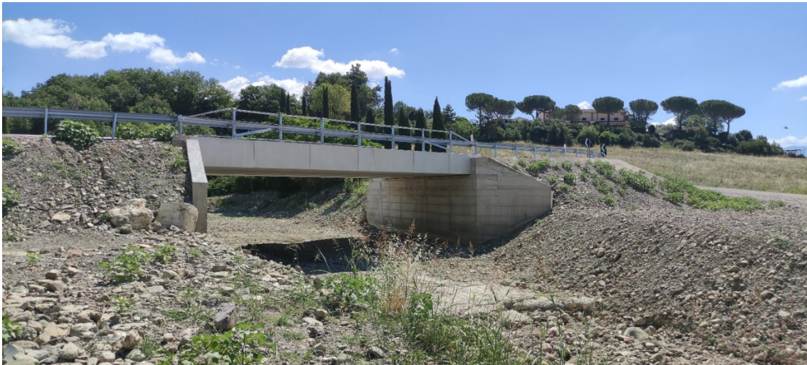
Figura 7-20 - Attraversamento stradale sul Torrente Spagnola
