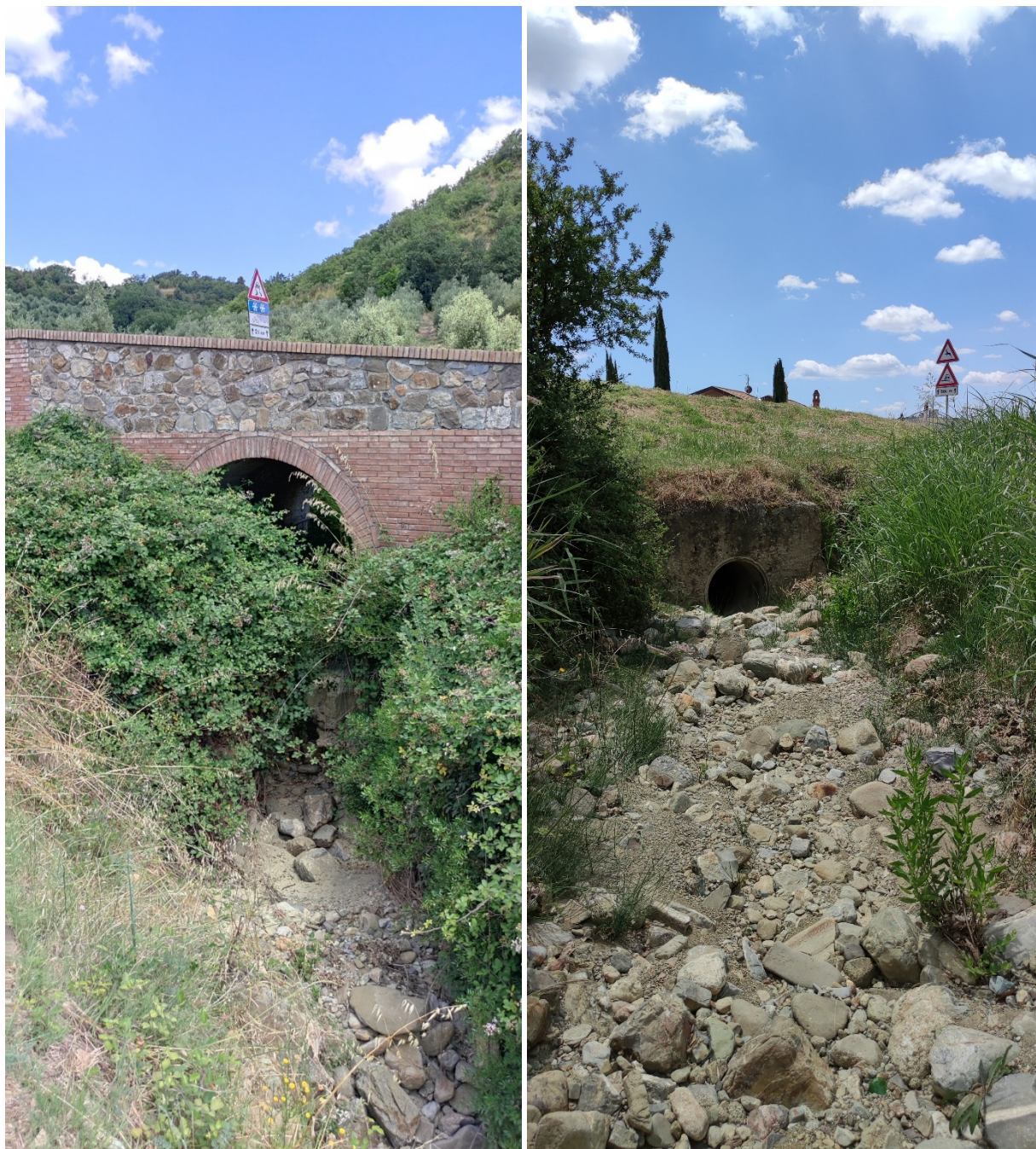
Figura 7-15 – Attraversamento e tratto tombato del corso d'acqua TS78736
