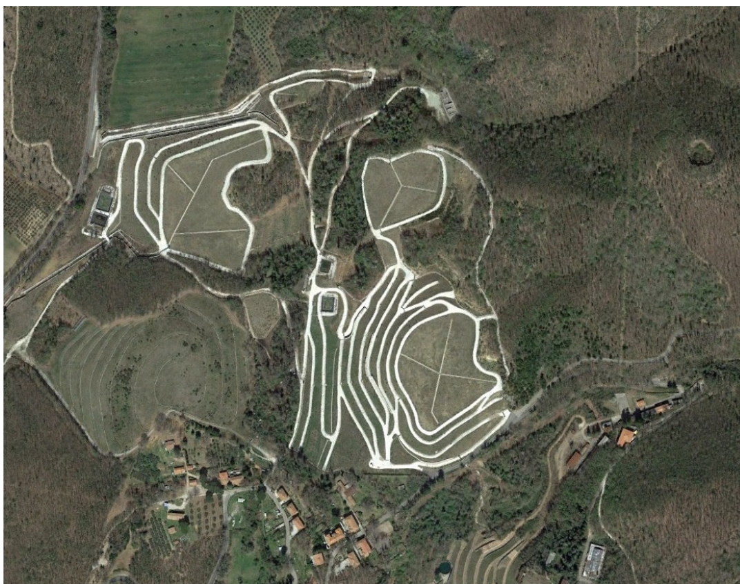
Le opere di bonifica della discarica mineraria di Niccioleta
