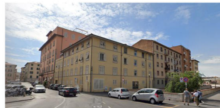
ESTRATTO FOTOGRAFICO: stato attuale
